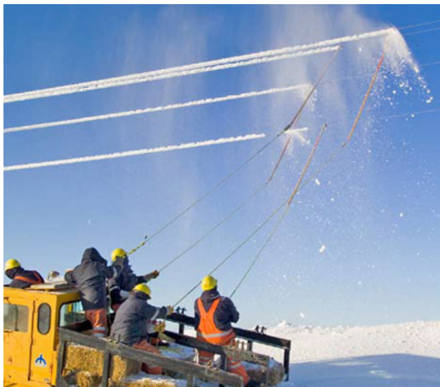
Slika 10: Odstranjevanje ledu s pomočjo škripca - ice rolling (vir: Manitoba Hydro, 2012)
