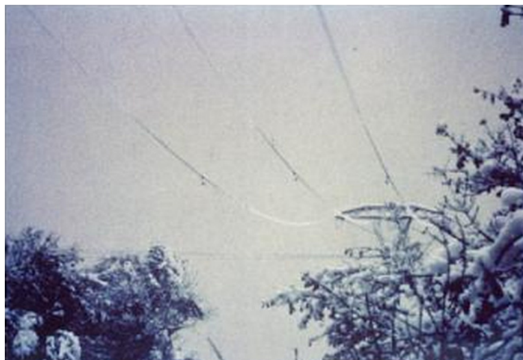
Slika 12: Protiteži na vodnikih 220 kV daljnovoda (vir: Farzaneh, 2008)
