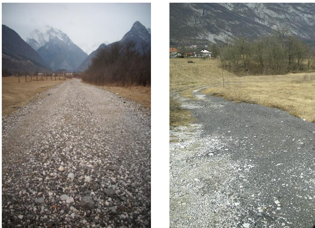
Slika 11: Uporaba asfaltnega granulata na manj pomembnih vozniških površinah
