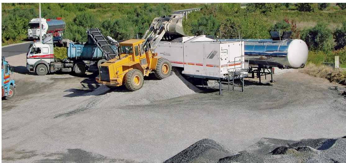
Slika 13: Izvajanje reciklaže v mešalni opremi (in-plant) (Wirtgen, 2010)
