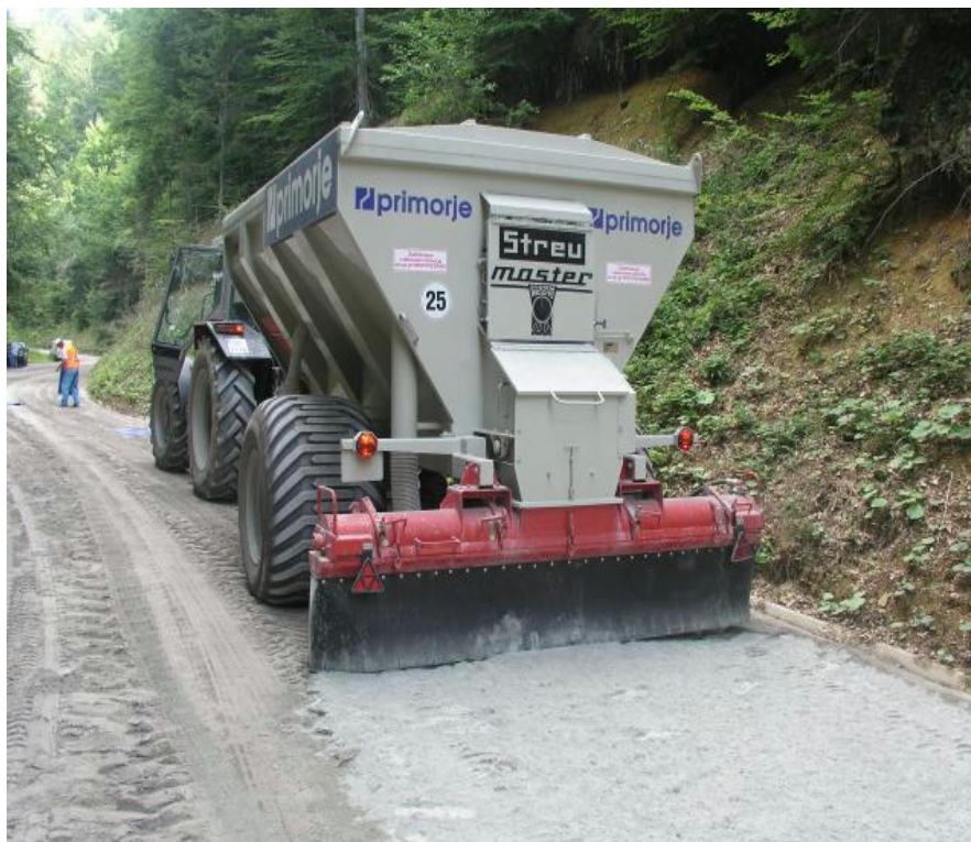
Slika 23: Posipavanje cementa (vir: Primorje)
