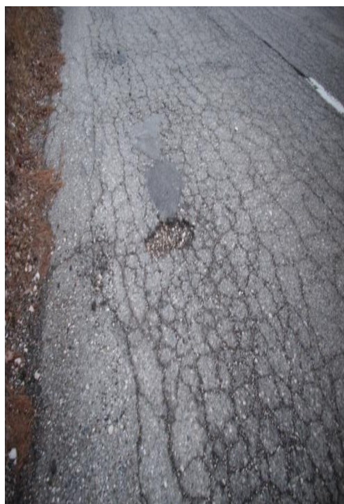
Slika 3: Udarne jama, ki ogroža varnost prometa
