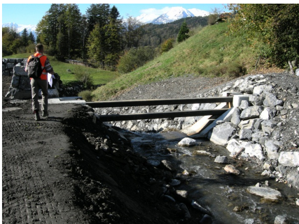
Fig. 17 Détail de l'aménagement d'une grille-seuil
