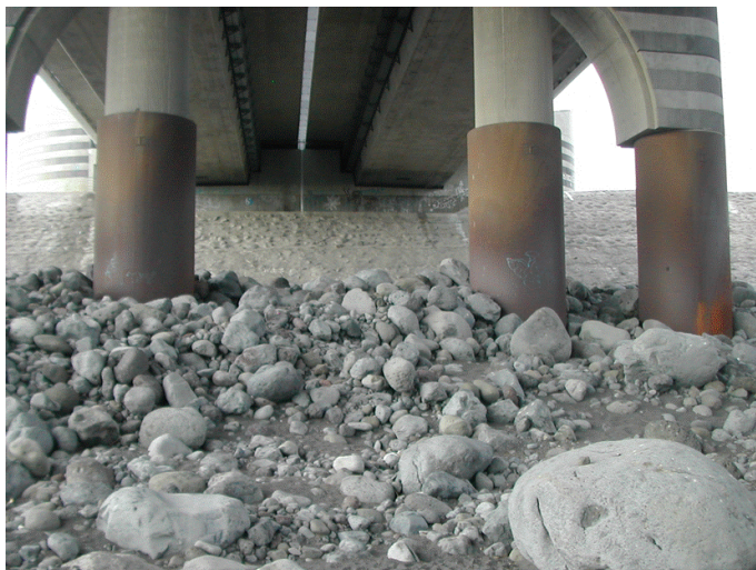
Fig. 2 Matériaux transportés par la Rivière des Galets sous le pont aval axe mixte, noter le blindage des piles
