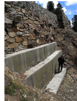
Fig. 7 Mit Betonvorbau sanierte Mauer (Photo S. Margreth)
