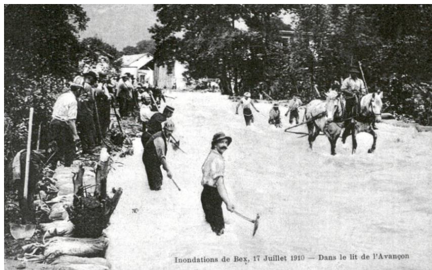
Fig. 2 Travaux de remise en état de l'Avançon après l'inondation de 1910 (Stucky SA, 2002)
