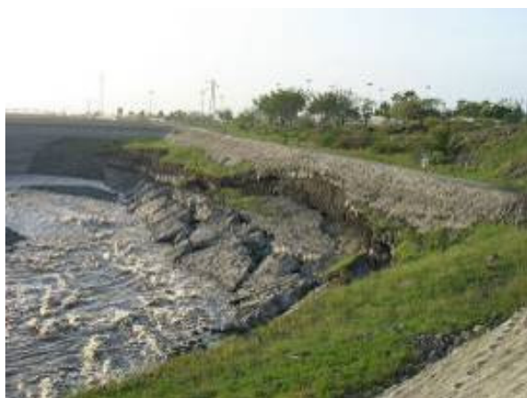
Fig. 10 Destruction RD digue entre épis, Cf. Fig. 4 Fig. 11 Souvèvement endiguement RG aval, Cf. Fig. 9
