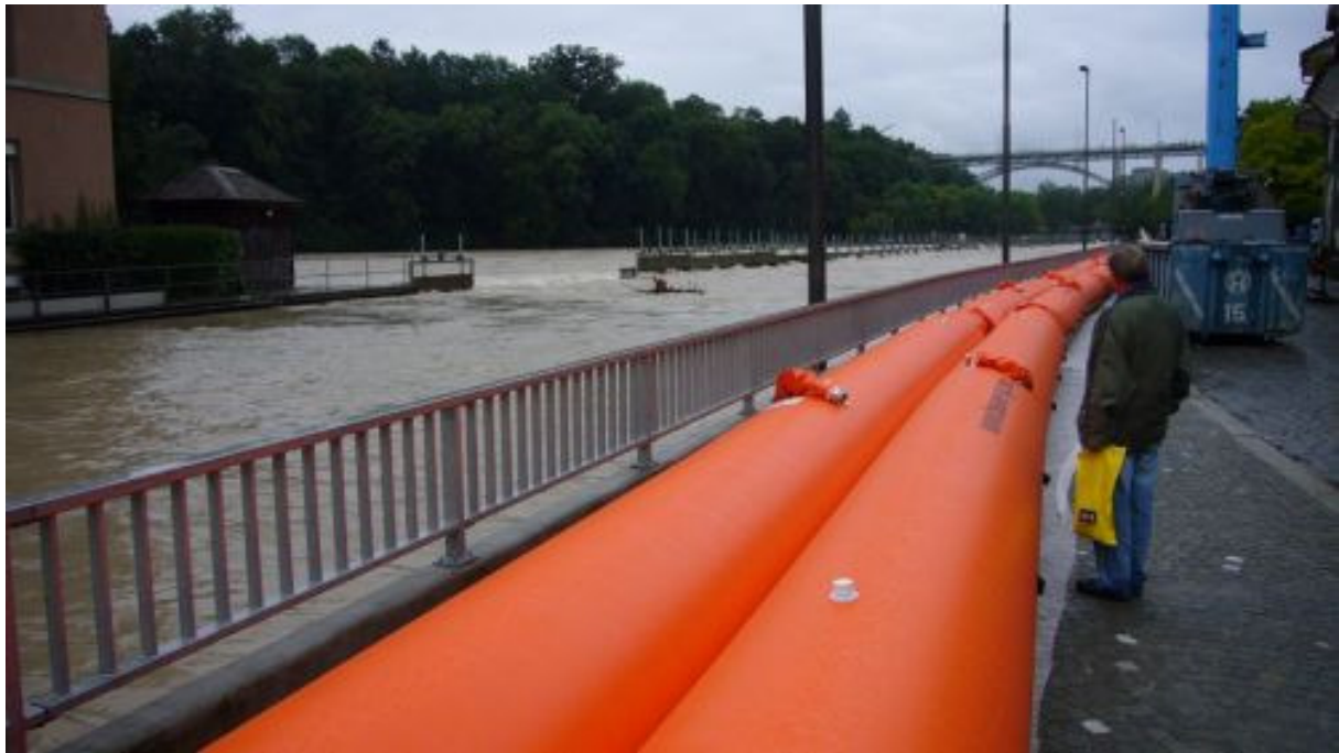
Fig. 2 Beaverschläuche als mobile Interventionsmassnahme im Mattequartier in Bern (Foto: Berufsfeuerwehr der Stadt Bern, 2007).
