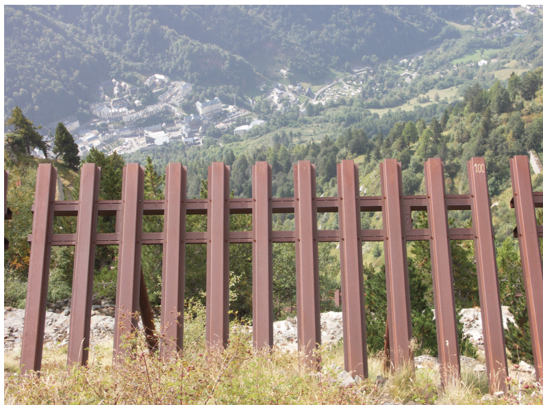
Fig. 1 Dispositif de protection active contre les avalanches
