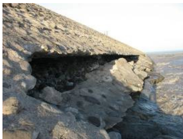
Fig. 10 Destruction RD digue entre épis, Cf. Fig. 4 Fig. 11 Souvèvement endiguement RG aval, Cf. Fig. 9
