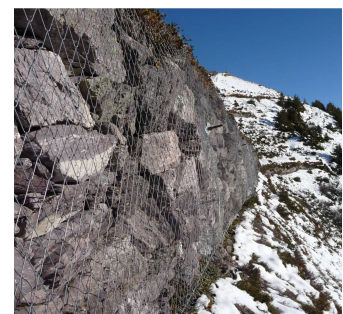
Fig. 9 Steinmauer mit rückverankertem TECCO-Drahtgeflecht (Photo M. Gächter)
