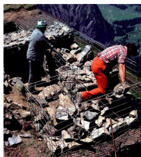
Fig. 8 Umbau von Steinmauern in Drahtsteinkörbe (Photo BLS)
