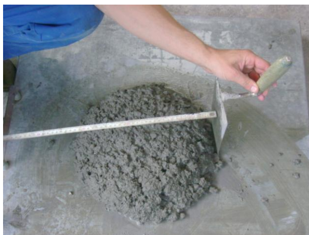
Slika 17: Merjenje razleza betonske mešanice
