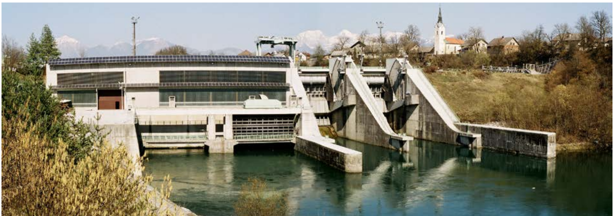
Fotografija 3: Hidroelektrarna Mavčiče, pogled gorvodno, 2007
