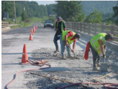
Slika 32: Priprava betonske površine
