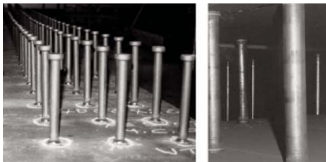
Slika 8: Primer jeklenih moznikov, ki so privarjeni na zgornjo površino jeklenega podpreza (t.i. Nelsonovi mozniki)
