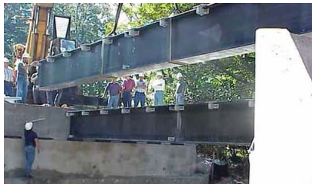
Slika 20: Menjava jeklenih mostnih nosilcev s FRP nosilci
