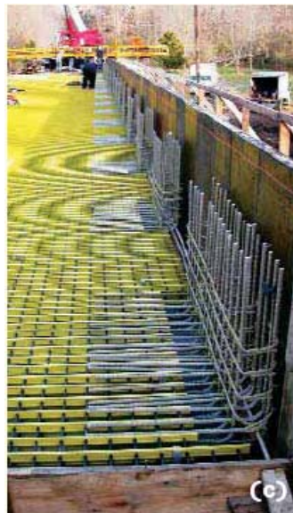
Slika 23: Namestitev armature za betonsko zaščitno ograjo
