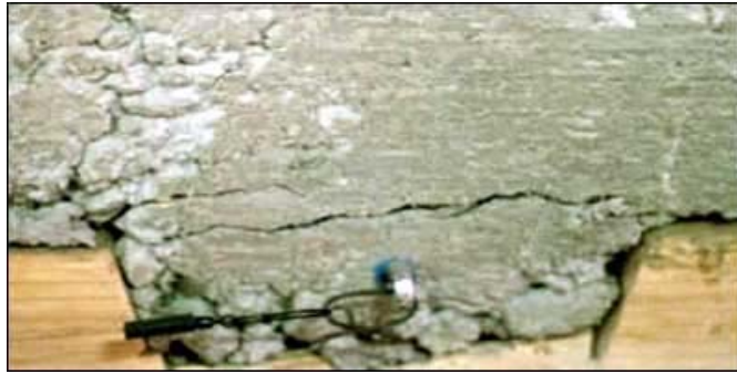
Slika 15: Primer stika les – beton
