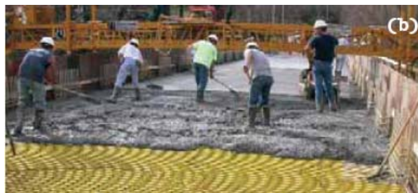
Slika 24: Voziščna plošča je bila končana v dveh urah in pol
