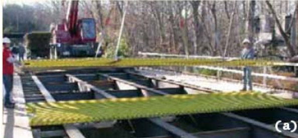
Slika 22: Instalacija FRP prefabriciranih plošč
