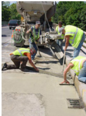
Slika 33: Betoniranje nove betonske plasti
