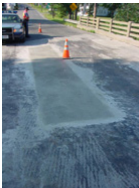
Slika 34: Obnovljeni del konstrukcije
