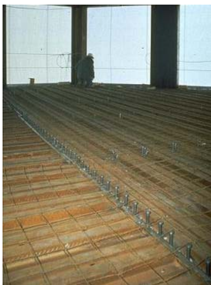
Slika 12: Namestitev potrebne armature
