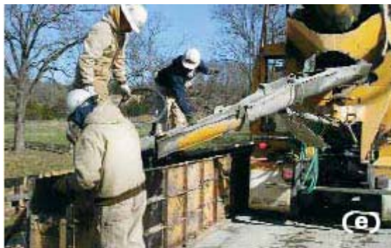
Slika 25: Izdelava betonske zaščitne ograje
