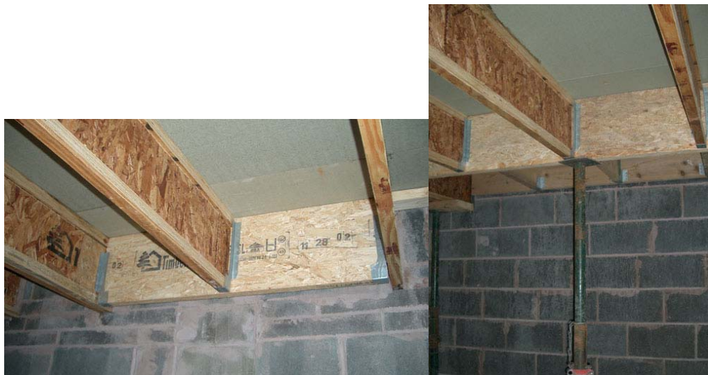
Slika 16: Primer kompozitne konstrukcije iz lesa in betona
