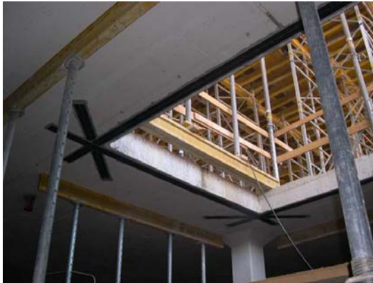
Slika 17: Primer utrditve armiranobetonske konstrukcije s FRP trakovi
