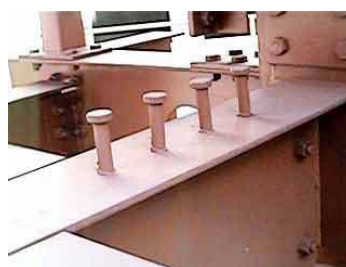
Slika 3: Primer jeklenih moznikov
