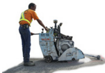
Slika 31: Odstranitev dotrajane betonske površine
