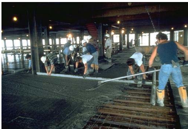
Slika 13: Zabetoniranje betonske plošče
