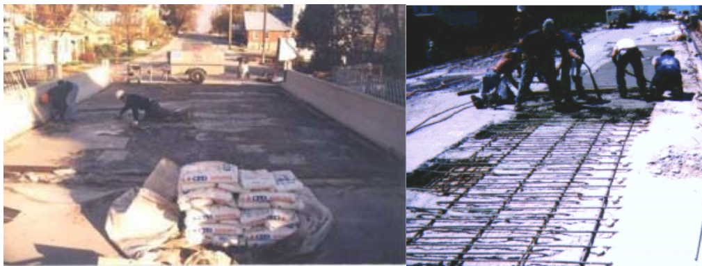
Slika 29, slika 30: Primera sanacije voziščne plošče mostne konstrukcije
