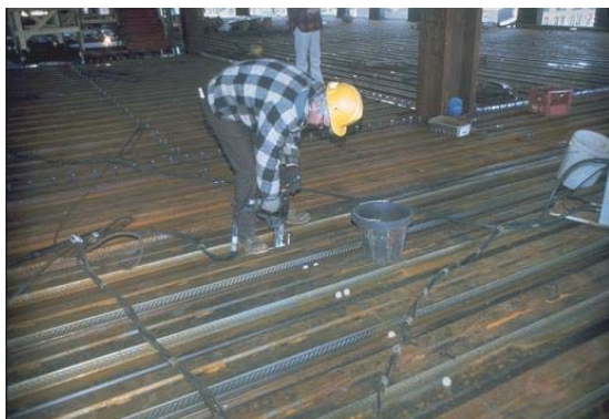
Slika 10: Namestitev hladno oblikovane pločevine na nosilno konstrukcijo
