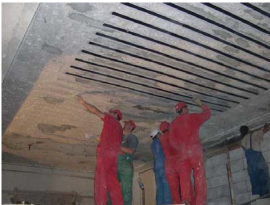
Slika 18: Primer sanacije stropne konstrukcije s FRP trakovi
