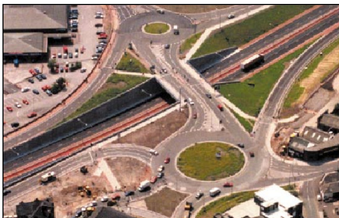
Slika 30 – Romb z dvema krožnima križiščema in z enim nadvozom ter okroglim centralnim otokom ( http://www.tfrc.gov/safety/00-0678.pdf )
