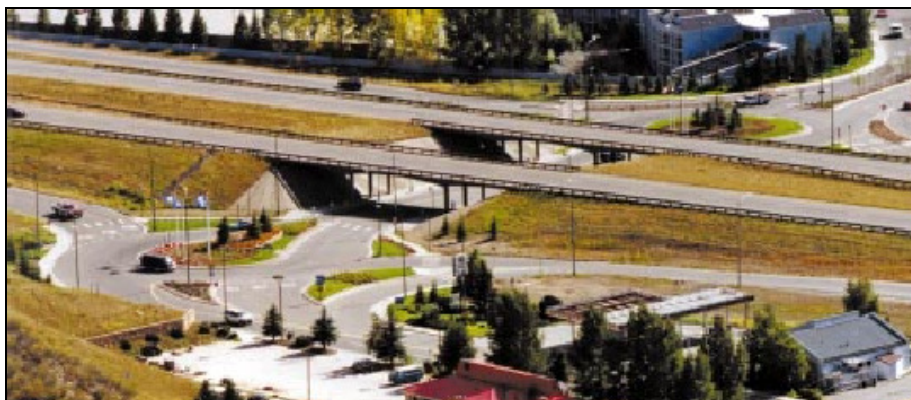
Slika 32 – Romb z dvema krožnima križiščema in z enim nadvozom ter otokom v obliki dežne kaplje ( http://www.tfrc.gov/safety/00-0678.pdf )
