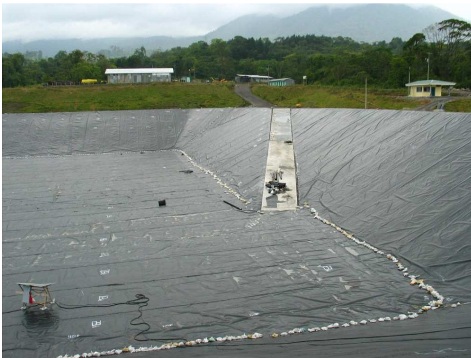
Izravnalni rezervoar (Arhiv Litostroj Power d.o.o.)
