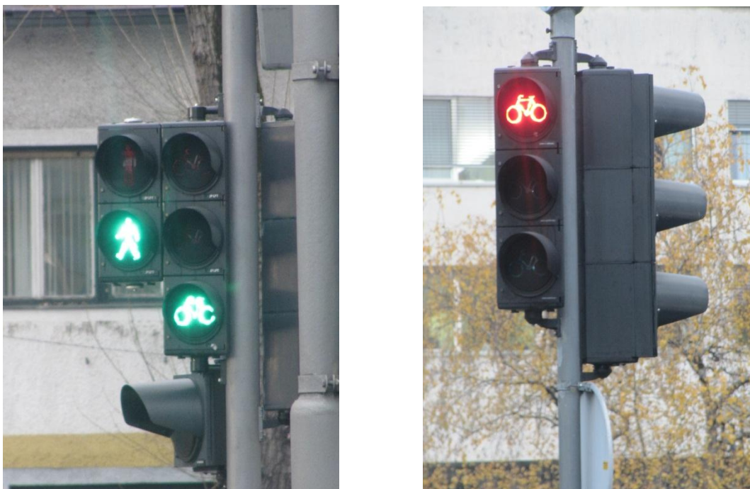
Slika 18: Možnosti postavitve semaforskih glav za kolesarje (levo - skupaj z pešci in desno - samostojno) – Ljubljana (Plava laguna).
