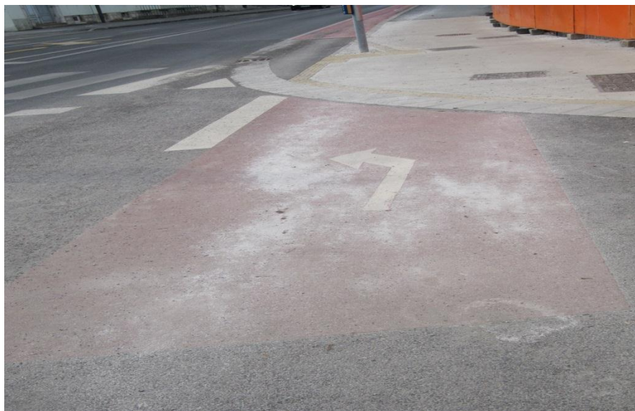
Slika 34: Zavijalni žep na vozišču, ki omogoča levo zavijanje proti kraku B
