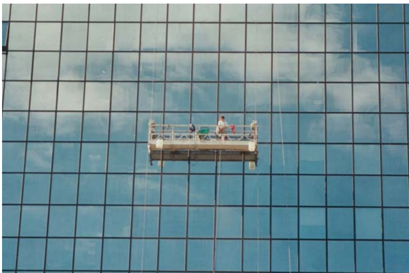
Slika 24: Delovna košara oziroma ploščad obešena na jeklenih vrveh
