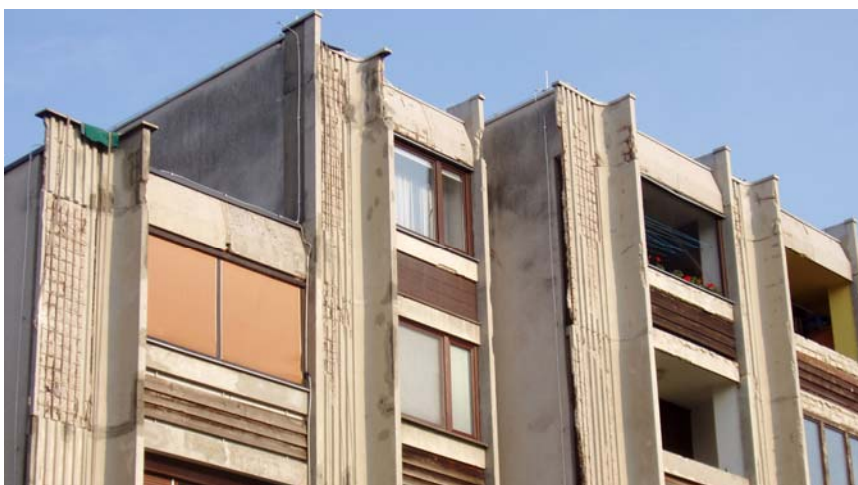
Slika 27: Objekt med sanacijo
