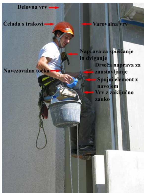
Slika 25: Delo v visečem položaju na vrvi z uporabo vrvne tehnike
