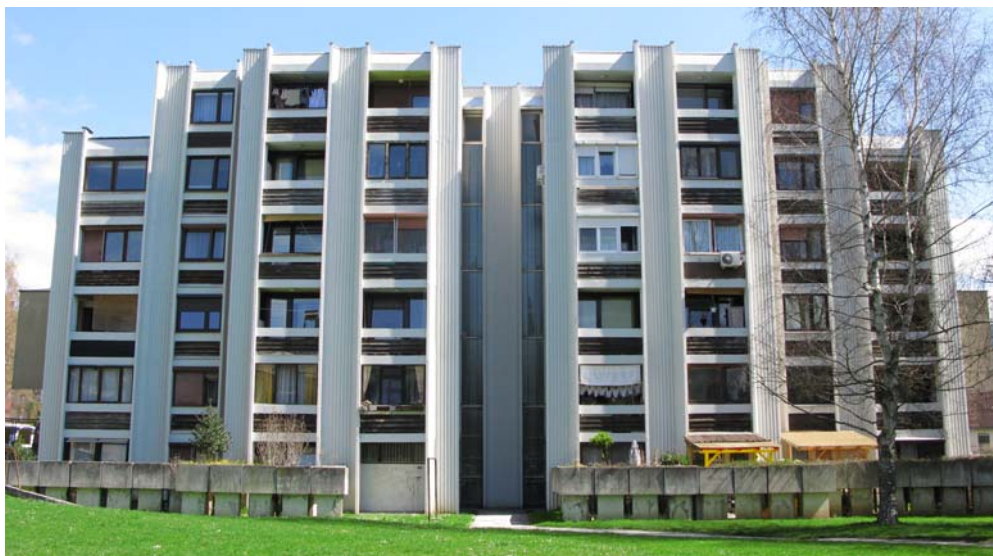
Slika 28: Objekt po sanaciji
