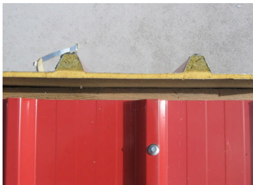
Slika 13: Prerez strešne kritine (Vir: Lasten arhiv)
