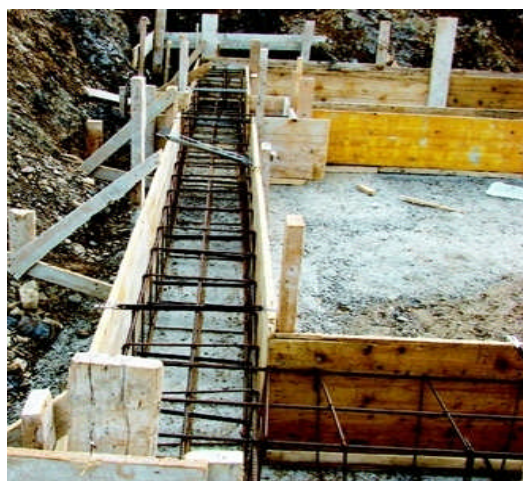
Slika 5: Položena armatura pasovnih temeljev (vir: Gabrič in drugi, 2008, 45)
