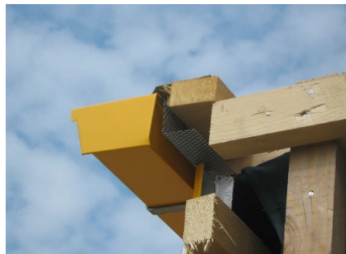
Slika 14: Namestitev mrežice (Vir: Lasten arhiv)
