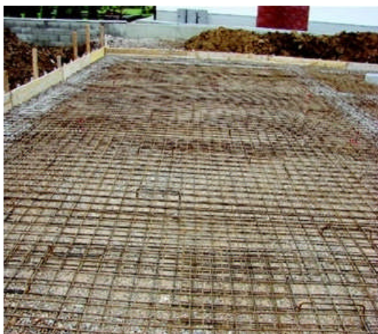
Slika 4: Položena armatura temeljne plošče (vir: Gabrič in drugi, 2008, 45)
