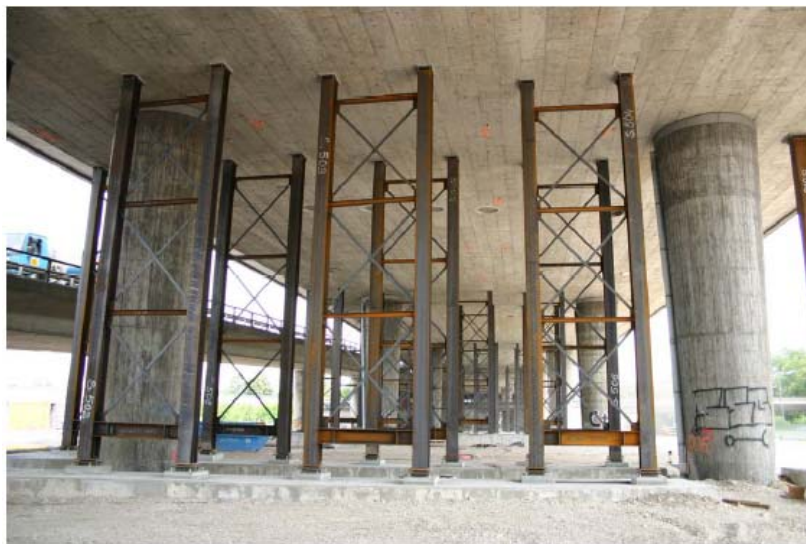
Slika 13: Podprta konstrukcija mostu (Schäfer, 2008)
