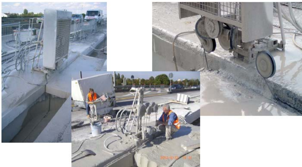
Slika 15: Postopek vzdolžnega prereza mostu (Schäfer, 2008)
