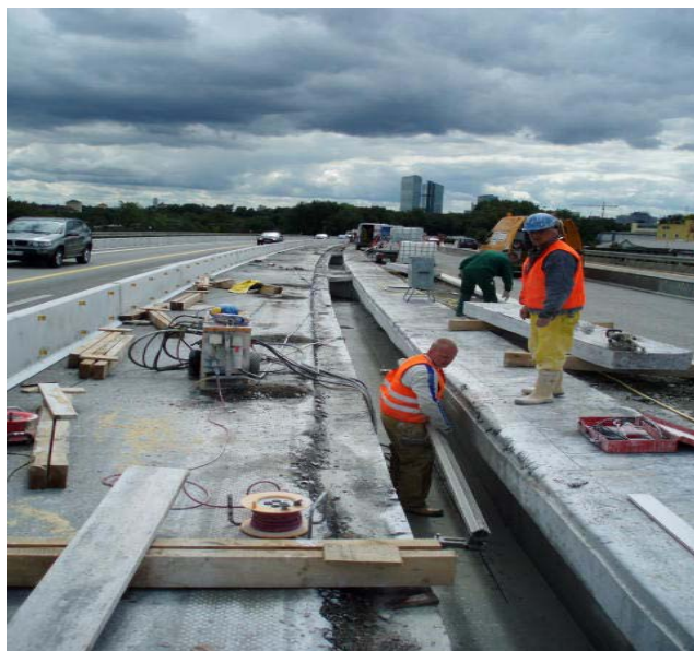
Slika 3: Prikaz obnovitvenih del na polovici mostu, na drugi polovici teče promet (Schäfer, 2008)
