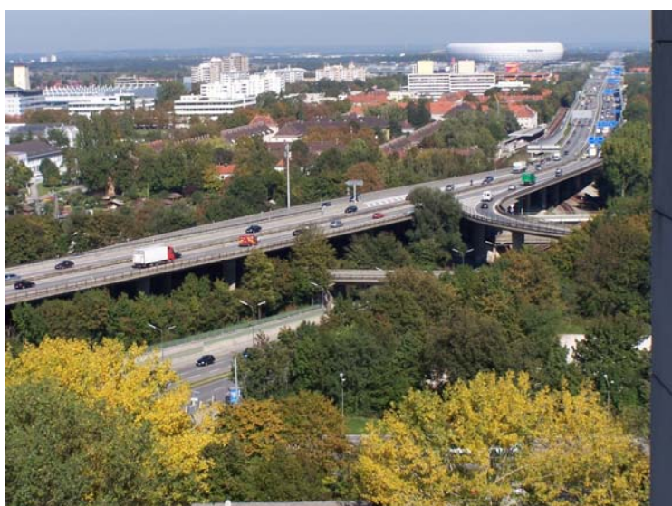
Slika 1: Pogled na most Freimann pred rekonstrukcijo (Autobahndirektion Südbayern, 2006)
