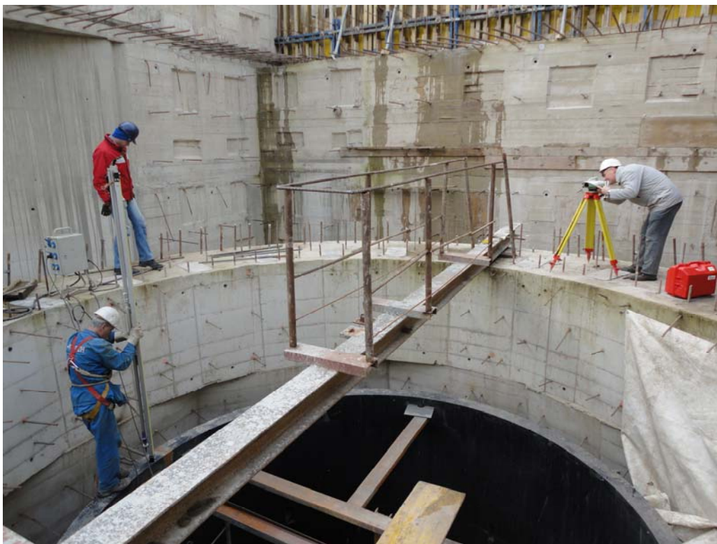
Slika 5: Meritev višinskih kot in centričnosti sesalne cevi pred betoniranjem na HE Krško
