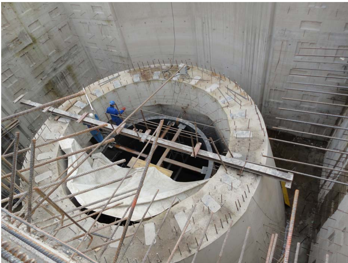
Slika 23: Gradnja turbinskega stebra na HE Krško
