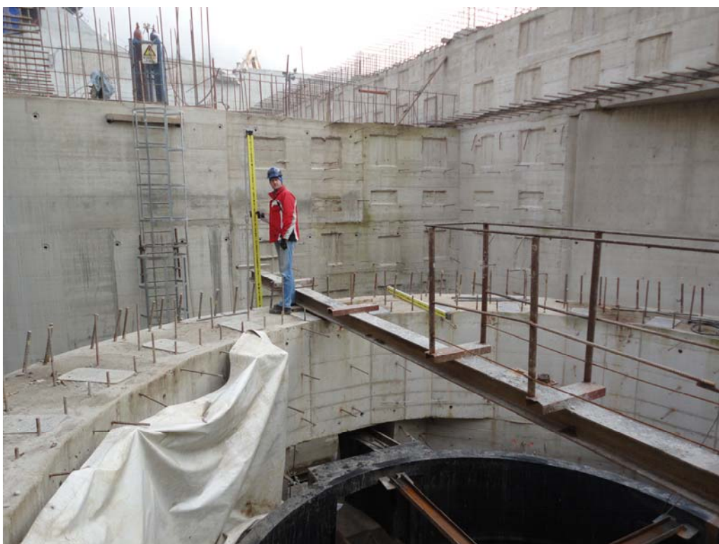
Slika 6: Navezava na reper turbinskega stebra HE Krško
