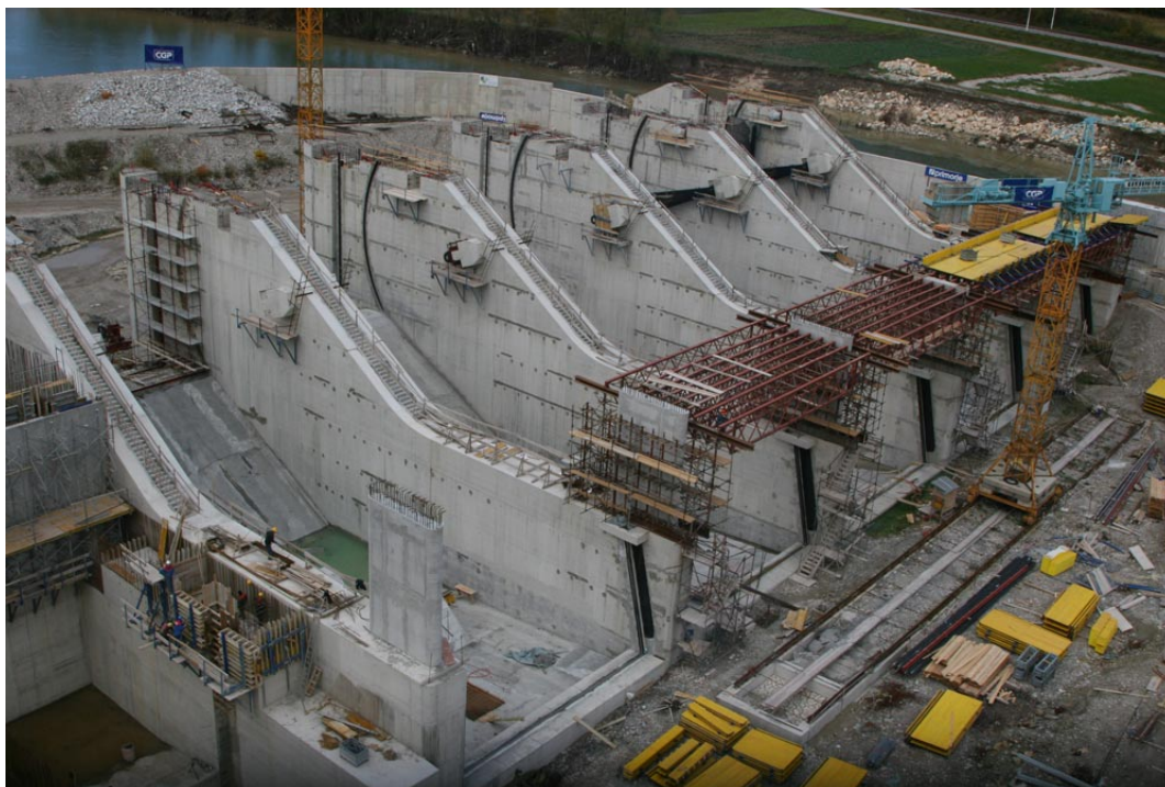
Slika 20: Prelivna polja v času gradnje
