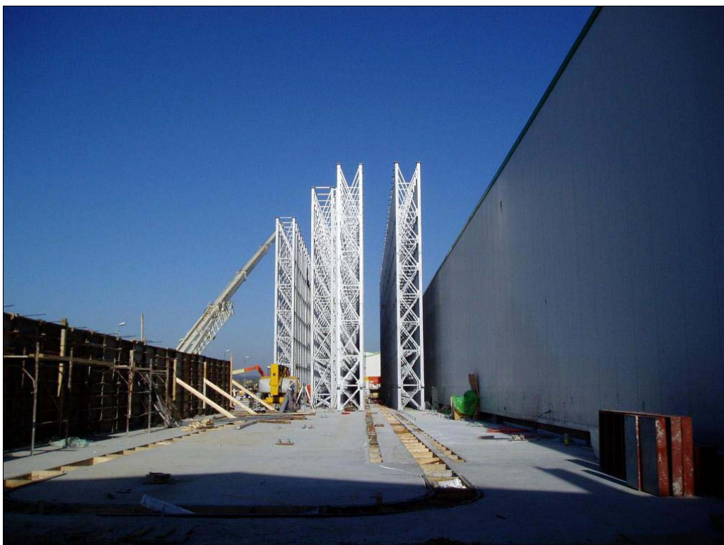
SLIKA 24: VRS 3 (tanke pločevine) v gradnji, 2007
