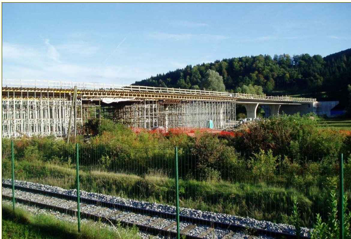
SLIKA 11: Viadukt pri Mercator centru Trebnje – v gradnji
