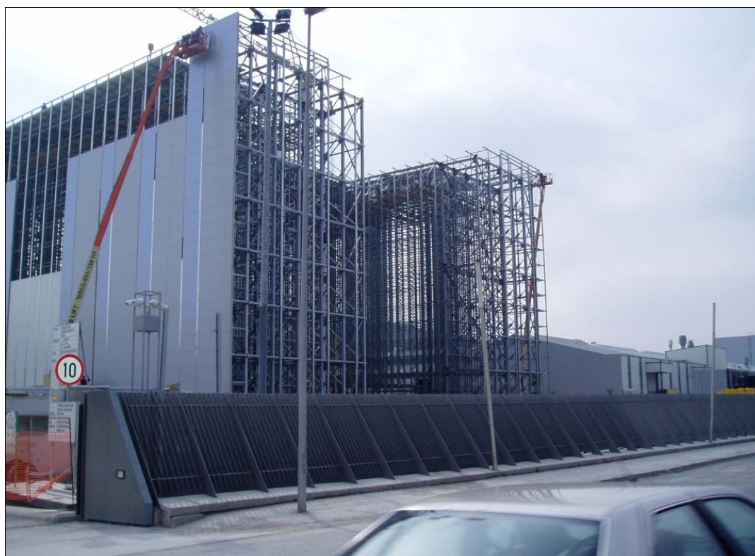
SLIKA 23: VRS 2 (gotovi proizvodi) v gradnji, 2006
