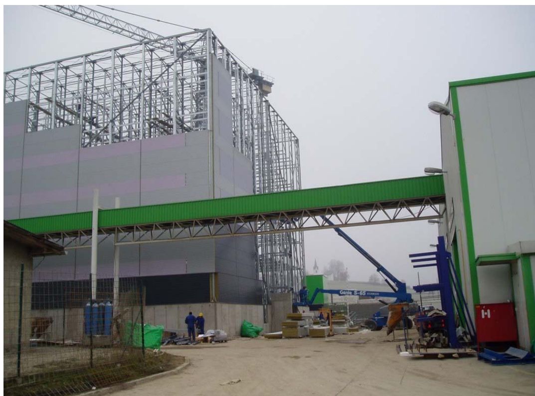
SLIKA 21: VRS 1 (vhodni materiali) v gradnji, 2004
