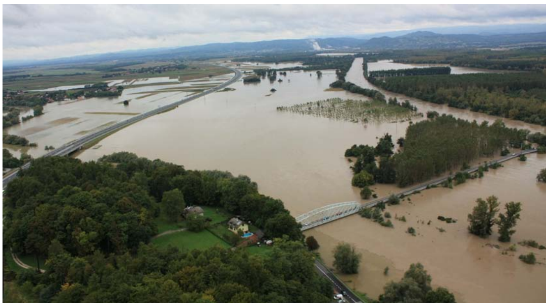
Slika 19: Pogled gorvodno na poplavljeno sotočje reke Save in Krke (Hidroelektrarne na spodnji Savi, 2011)
