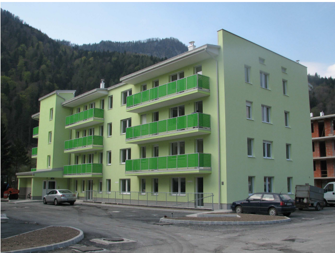
Slika 2.5: Izveden objekt (pogled s severne strani)
