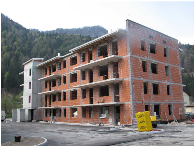
Slika 2.3: Objekt v času gradnje
