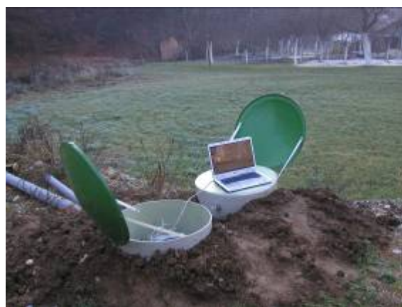
Slika 29: Vnos krmilnega programa iz računalnika na stikalno uro (15.10.2006)
