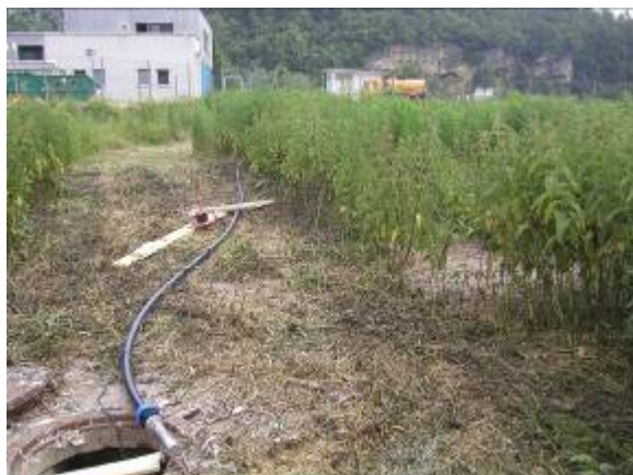
Slika 9: Alkatenast tlačni vod - pogled iz dotočnega jaška (27.8.2006)
