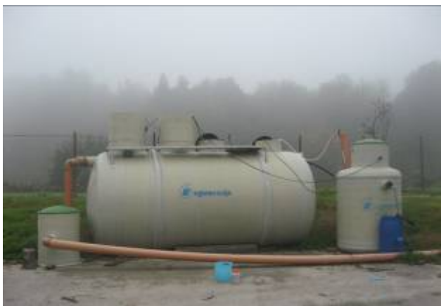
Slika 8: Postavitev pilotnih ČN (9.10.2007)
