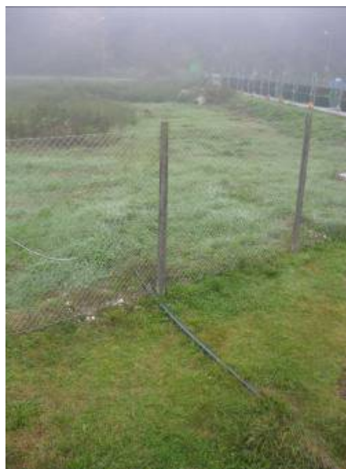
Slika 11: Alkatenast tlačni vod - pogled iz MČN SBR (9.10.2007)
