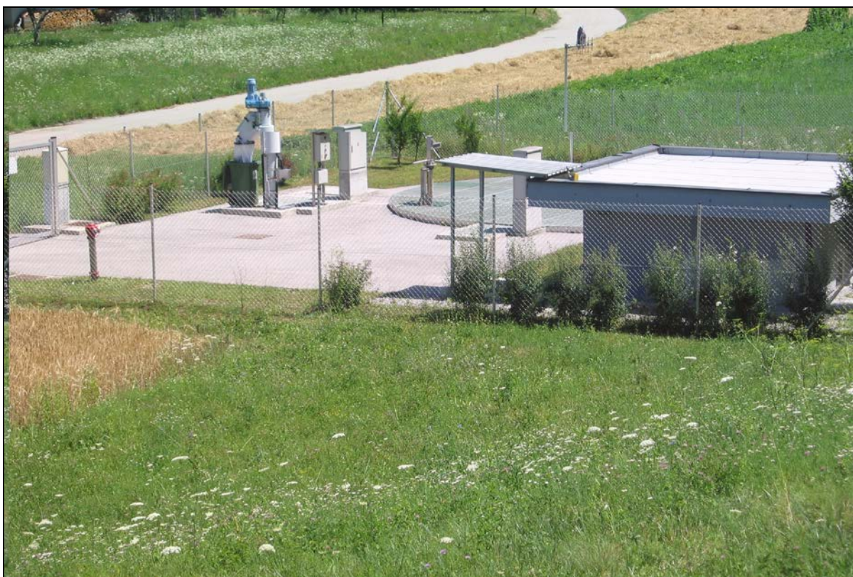
Slika 4: Biološka čistilna naprava BIOtip v naselju Brusnice za 600 PE
