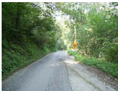
slika 29: zelo ozka cesta z grbinami in razpokami
