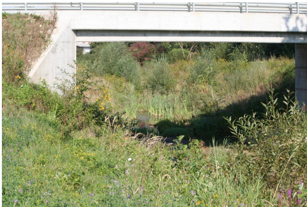
Slika 1: Mostna konstrukcija na novi strugi V. Ložnice (Vir: Hidrosvet d.o.o., 2010)
