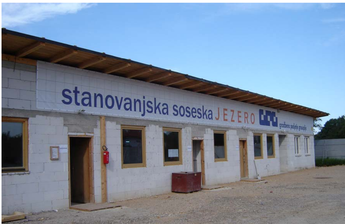
Slika 12: Začasni zidani objekt
