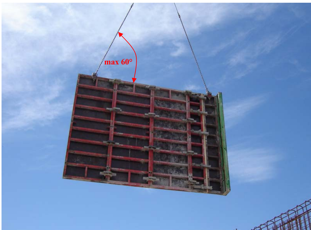
Slika 28: Prenos sestavljenih elementov z žerjavom in dvižnimi kljukami
