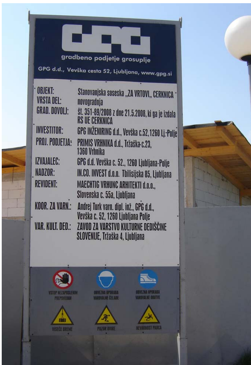
Slika 9: Gradbišćna tabla z opozorilnimi znaki
