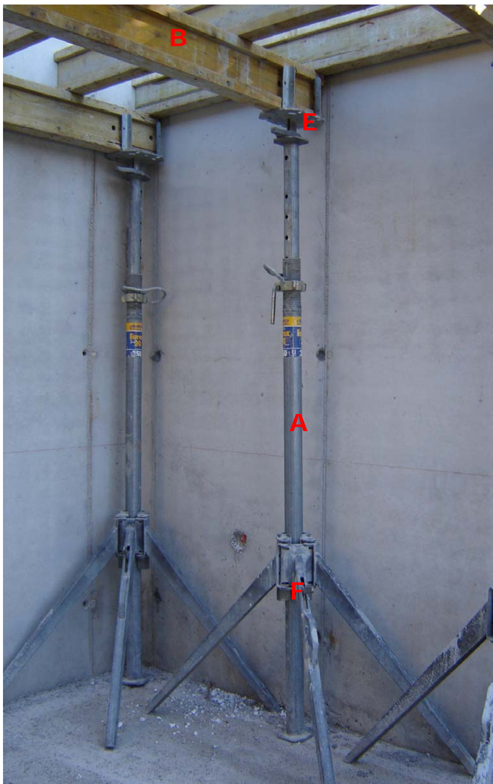
(A = stojka Eurex; B = nosilec H 20 top; E = pogrezna glava; F = stojalo za stojko)
