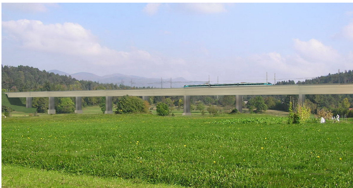
Slika 11: Viadukt V8 pri Matenji vasi
