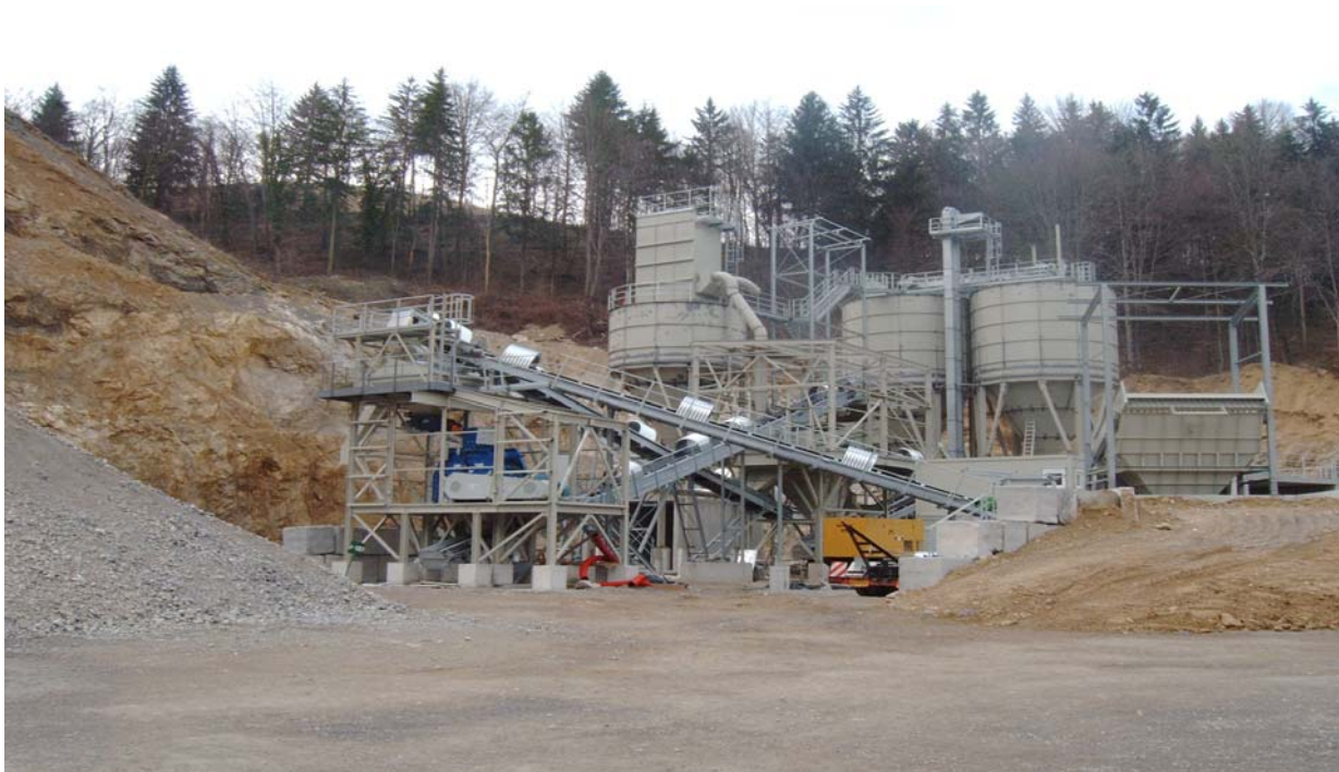
Slika 8: Primer stacionarne naprave za pridobivanje frakcij pri recikliranju odpadnih gradbenih materialov v Sloveniji (Ekoplan - Polzela)
