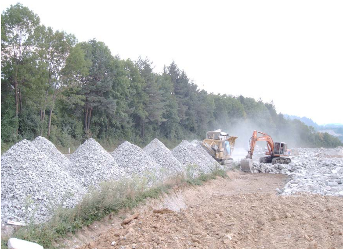
Slika 3: Primer reciklaže betonskega vozišča v kraju Naklo (stara cesta)
