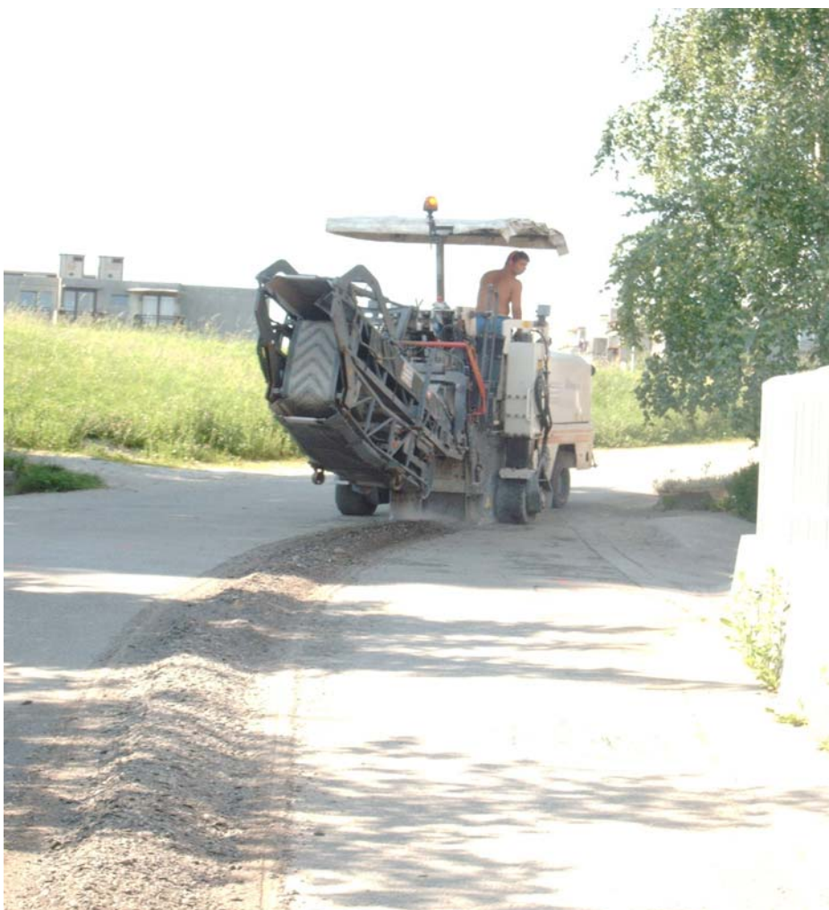
Slika 2: Primer rezkanja asfaltnega vozišča (za potrebe javne infrastrukture)
