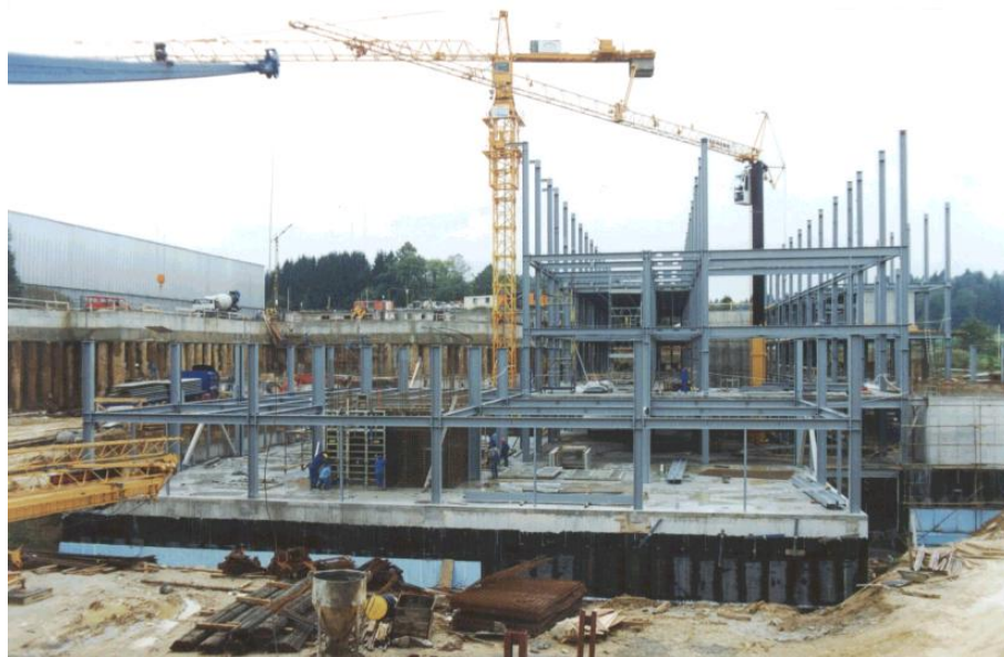
Slika 21: Gradnja tovarne za proizvodnjo tablet- Notol 1,2,3; Novo mesto (interno gradivo Begrad-a d.d.)
