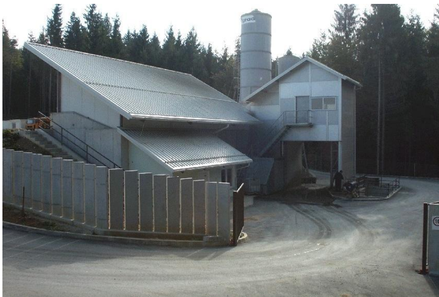
Slika 13: Betonarna v Novem mestu (interno gradivo podjetja Begrad d.d.)
