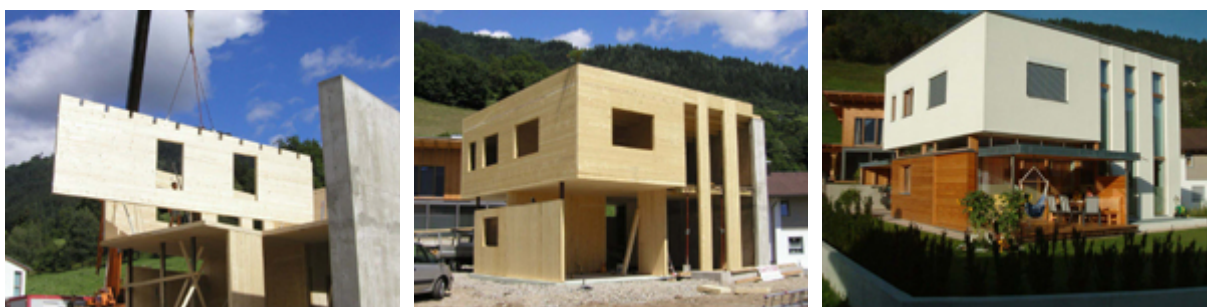
Slika 8: Gradnja montažne hiše iz KLH elementov
