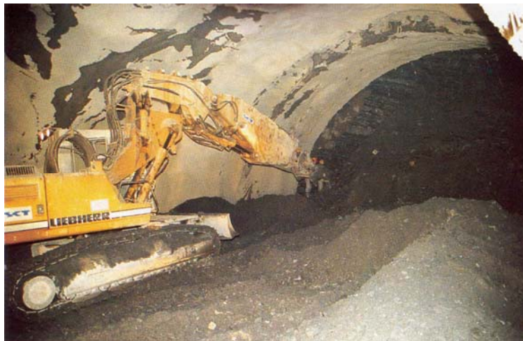
Slika 12: Liebherr bager - prilagojen za delo v predoru (Vir: Teh. Informator SCT: December 1999)
