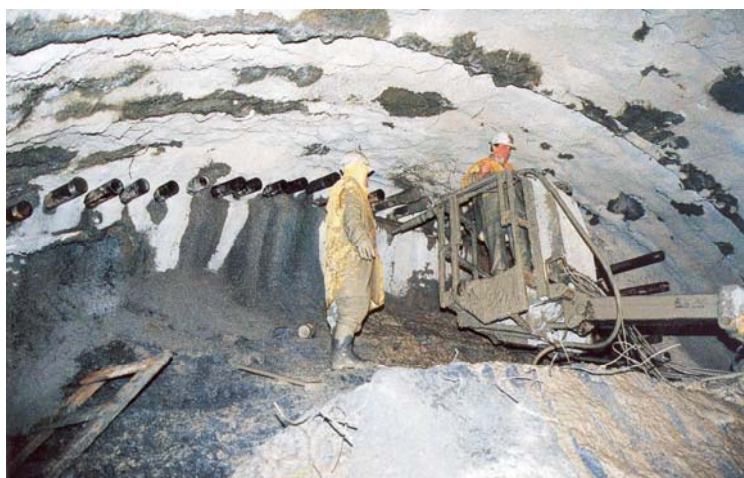
Slik 16: Vgradnja cevnega ščita (Vir: Teh. Informator SCT: December 1999)
