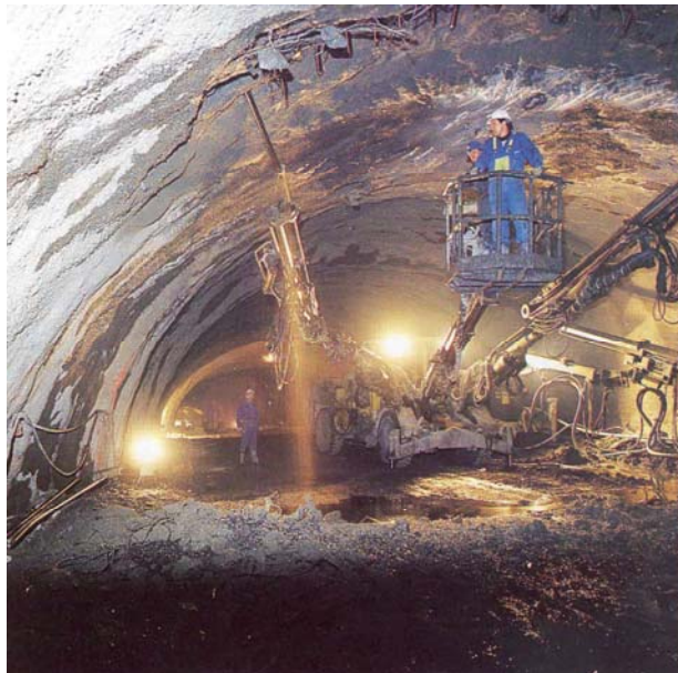
Slika 8: Sanacijska dela primarne obloge (Vir: Teh. Informator SCT: December 1999)
