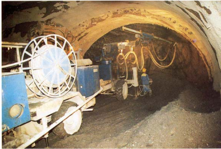
Slika 14: Vgradnja mikroarmiranega brizganega betona (Vir: Teh. Informator SCT: December 1999)
