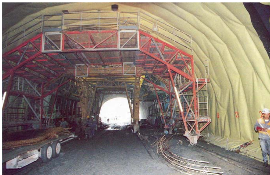
Slika 9: Priprava predora za vgradnjo notranje obloge (Vir: Teh. Informator SCT: December 1999)
