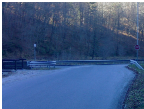
Slika 18: Lokalna cesta iz smeri Šentilja (Vodosteč)
