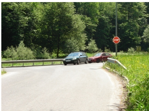
Slika 17: Lokalna cesta iz smeri Šentilja (Vodosteč)
