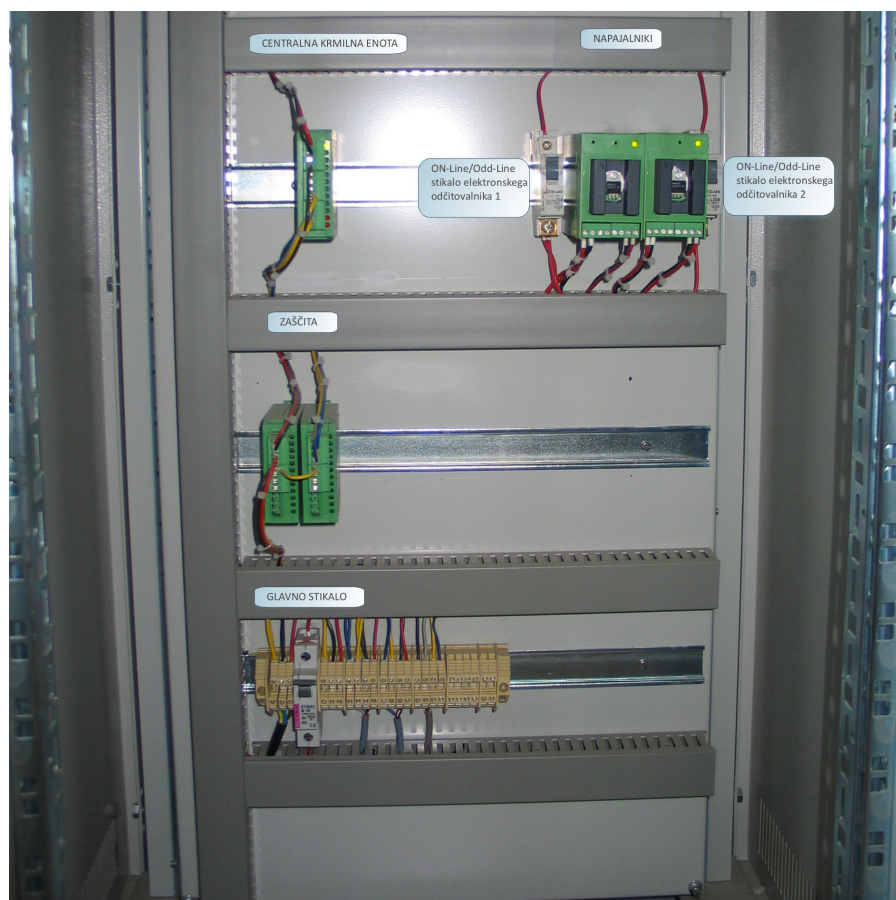
Slika 20: Fotografija krmilne omare DMS Memo v laboratoriju KMTAL
