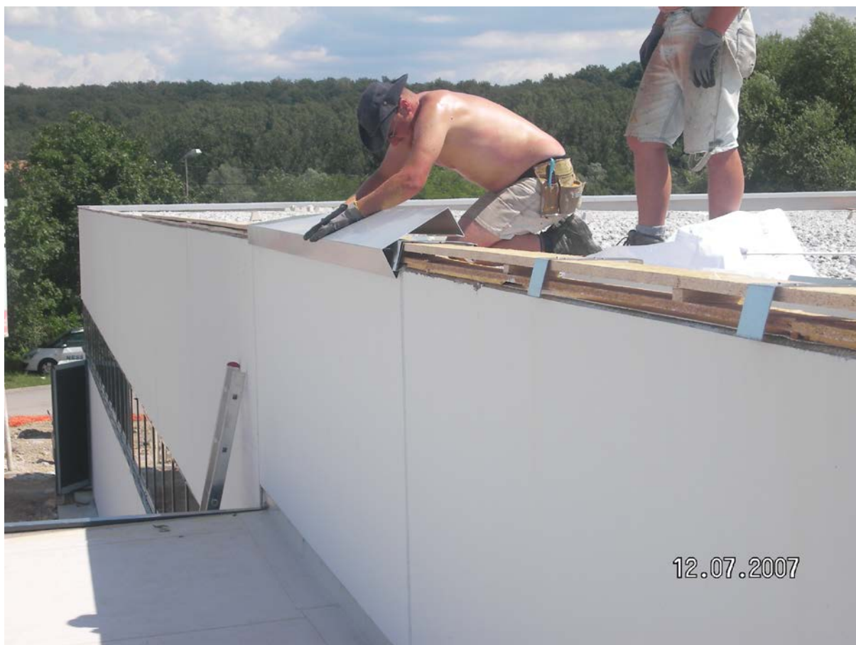
Slika 16: Začetek montaže pločevine atike
