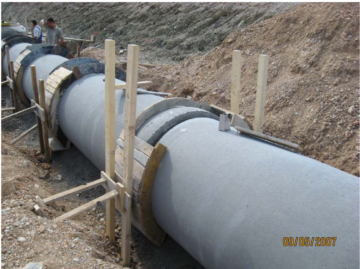
Slika 14: Izmenjevalec zraka
