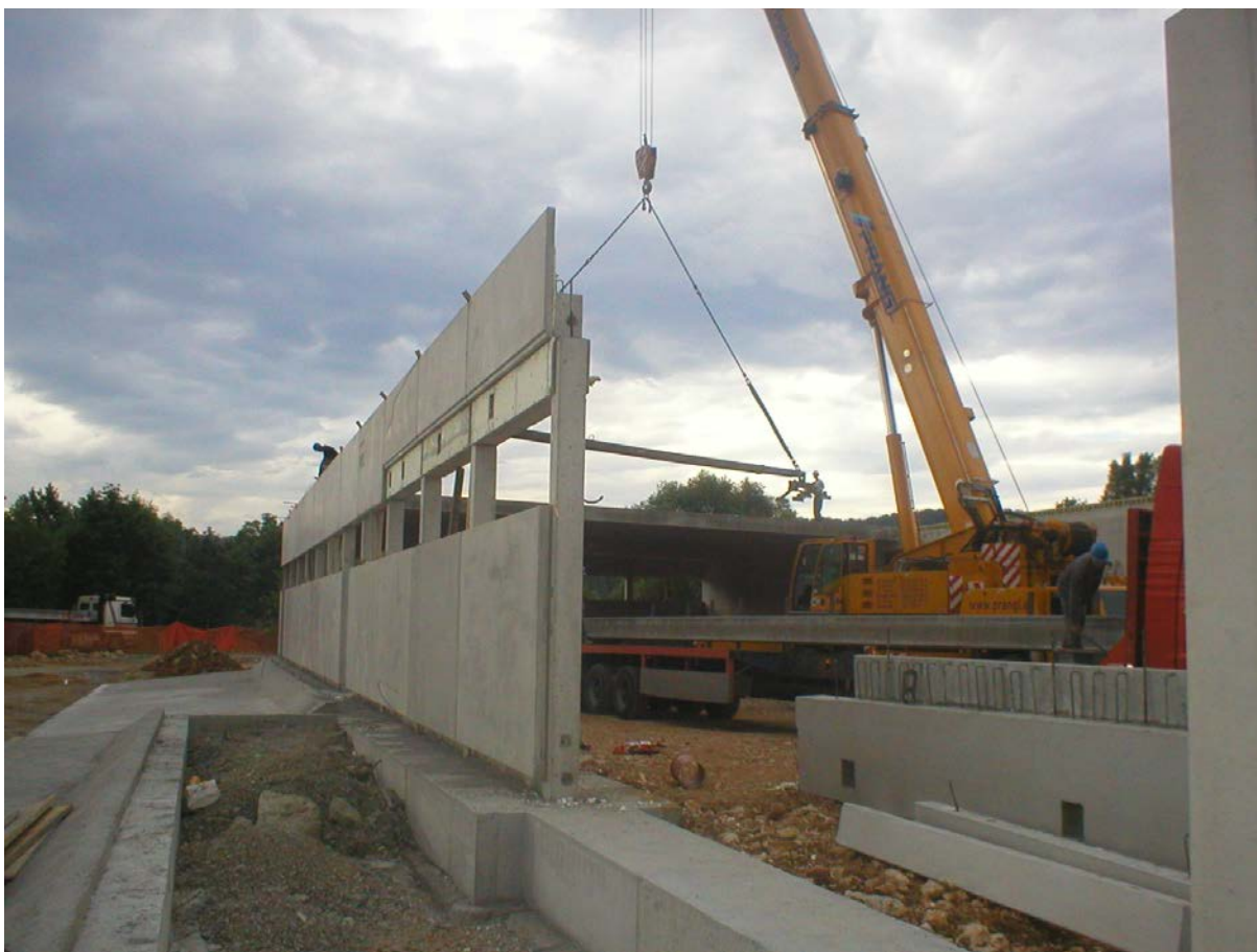
Slika 17: Izvedba montaže betonske konstrukcije objekta (gotovi elementi)
