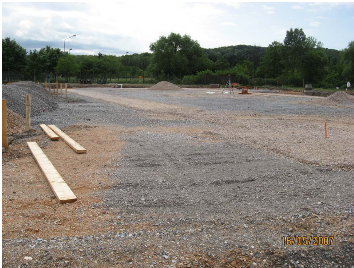
Slika 15: Stanje na gradbišču na tretji planirani delovni dan
