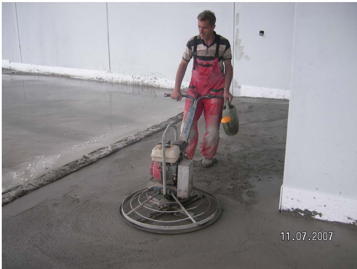
Slika 19: Zaključek izvedbe rampe
