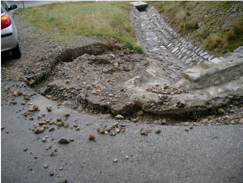
Slika 22: Erodiranje odvečne vode iz AC
