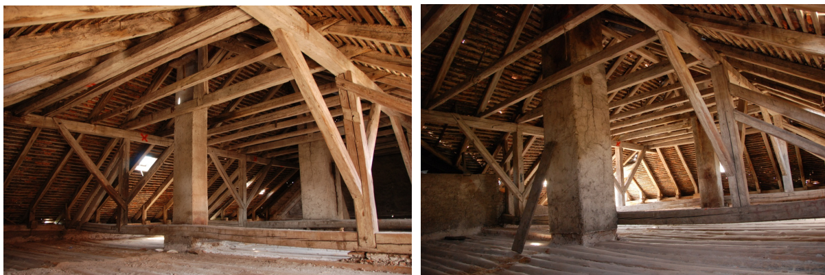
Slika 8.3 in 8.4: Ostrešje pred odstranitvijo. Severozahodna stran (levo), jugovzhodna stran (desno).
