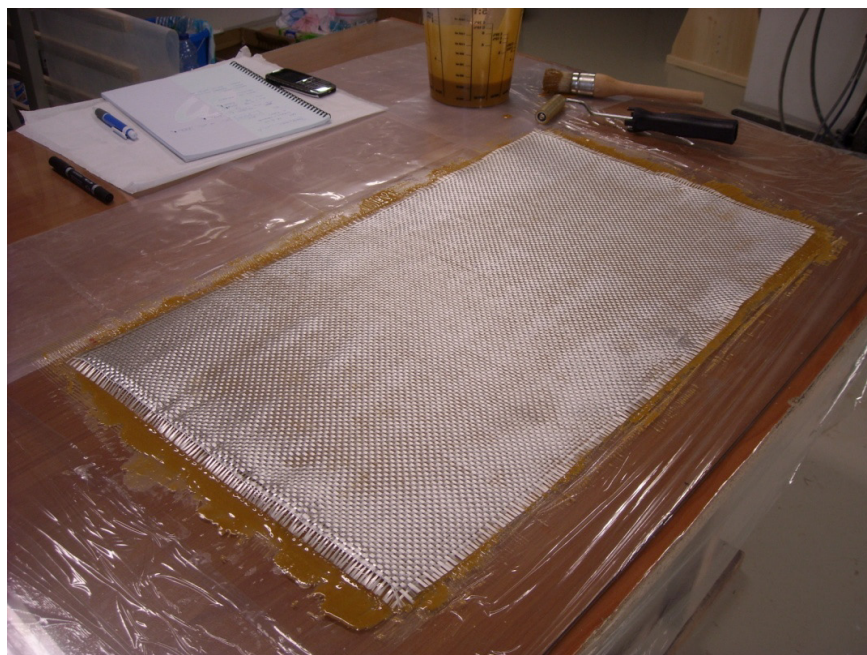
Slika 7.3: Impregnacija steklene tkanine z epoksi smolo za sanacije lesenih konstrukcij – 3. plast
