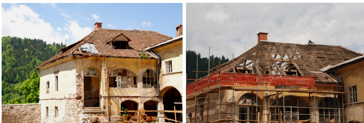
Slika 8.1 in 8.2: Lovski dvorec gradu Kieselstein. Stanje pred sanacijo (levo), odstranjevanje strešne konstrukcije (desno).
