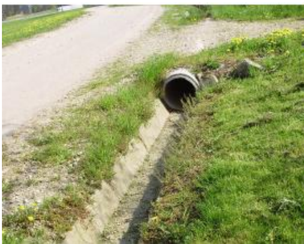
Slika 18: Primer odprtega meteornege kanala (Vir: Lebeničnik, 2010)
