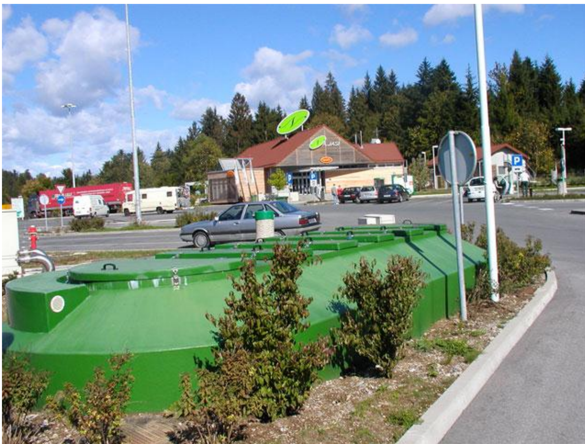
Slika 25: Končni izgled nadtalnega dela čistilne naprave Bioclere tipa B 500 (Vir: http://www.sezam-race.si )
