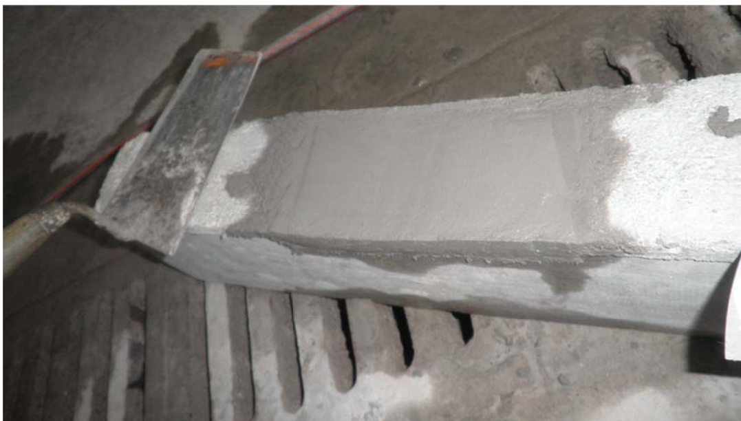
Slika 37: Nanos sanacijske malte na betonski vzorec
