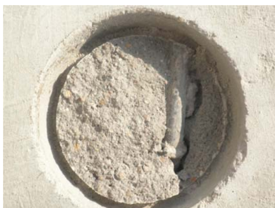
Slika 50: Prikaz porušene površine Pull-off testa pri vzorcu 11 (malta Emaco S80 in obdelava betonske površine z vodnim curkom)
