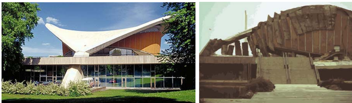
Slika 2: Kongresna hala v Berlinu zgrajena leta 1957 in delna porušitev 23 let kasneje
