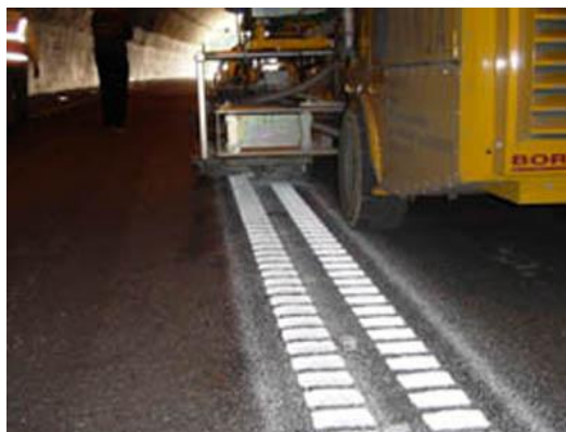
Slika 7: Nameščanje ropotne črte iz vroče plastike (Salonit Anhovo d.d.)
