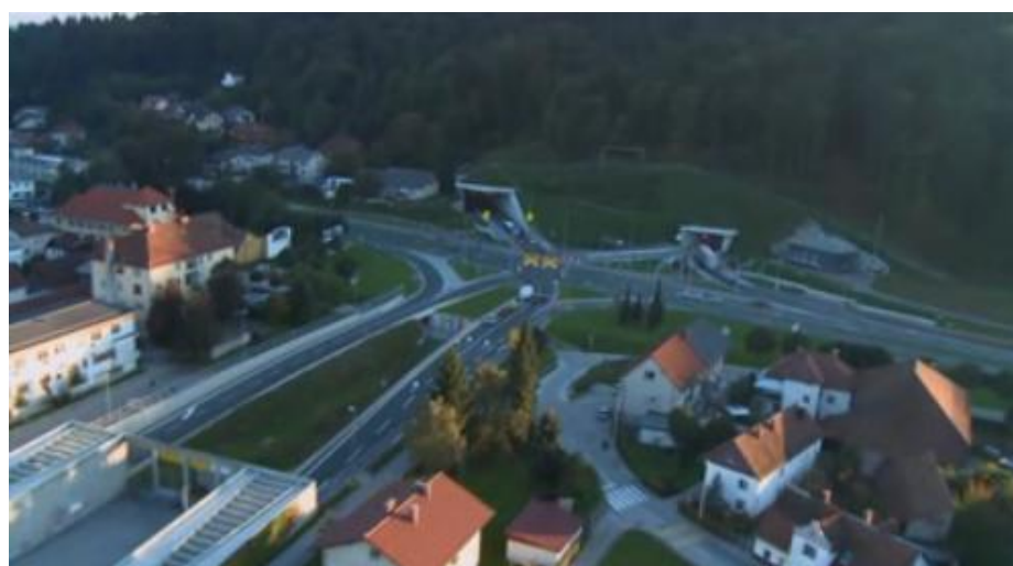
Slika 32: Priključni cevi predora Šentvid na Celovško cesto (DARS d.d)
