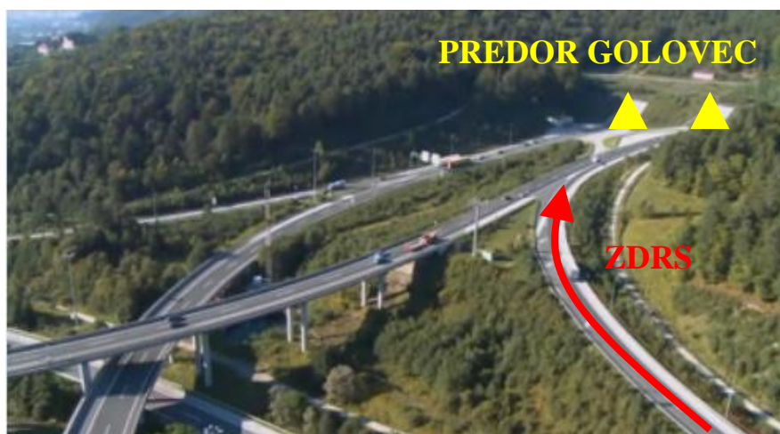
Slika 9: Prikaz problematičnega ovinka pred predorom Golovec (GURS)
