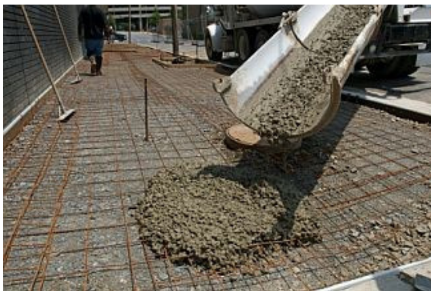
Slika 6: Vgrajevanje betona.
