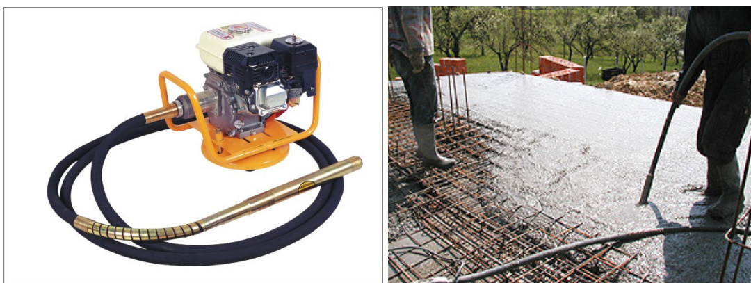
Slika 8: Vibrator za beton.
