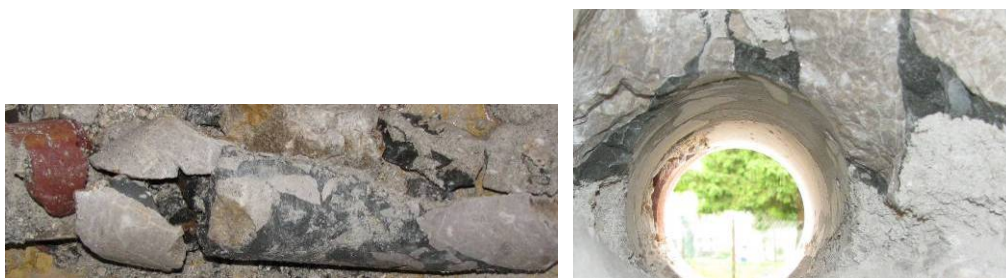
Slika 5.31: Jedro in globinska sonda, izvedena na osrednjem delu zidu 1-C1 Fig. 5.31: Core and in-depth probing in the middle of the wall 1-C1
