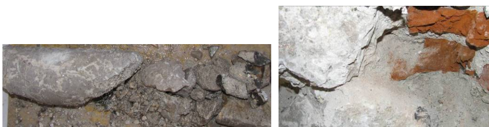
Slika 5.30: Jedro in globinska sonda, izvedena ob vpetju zidu 1-C1 Fig. 5.30: Core and in-depth probing at the bottom of the wall 1-C1
