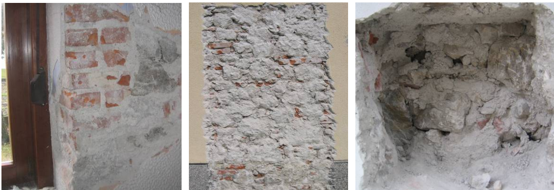
Slika 5.18: Izvedba površinskega (POZ 1-C1) in globinskega sondiranja (POZ 9) zidu Fig. 5.18: Surface (POS 1-C1) and in-depth probing (POS 9) of the wall
