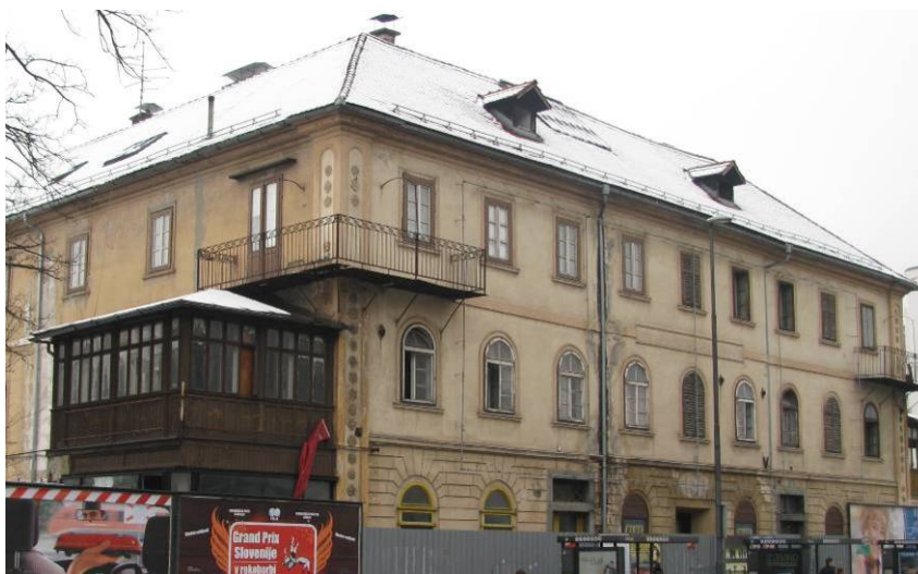
Slika 2.13: Kolizej zgrajen leta 1846, kot predstavnik rundbogenstila Fig. 2.13: Kolizej built in 1846 as a representative of Round-arch style
