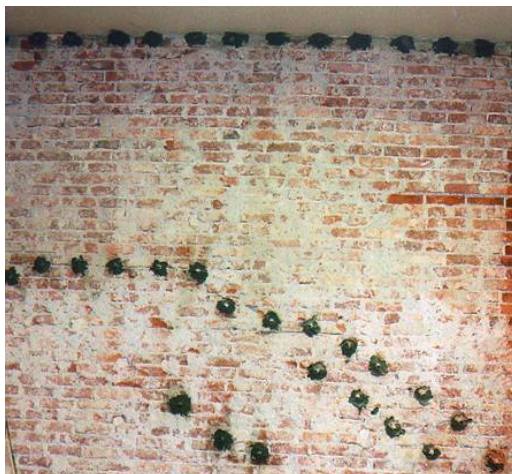
Slika 2.28: V zid vgrajeni nastavki pripravljeni za izvedbo linijskega injektiranja razpok Fig. 2.28: Set up of injection pipes for injection of cracks in brick masonry wall
