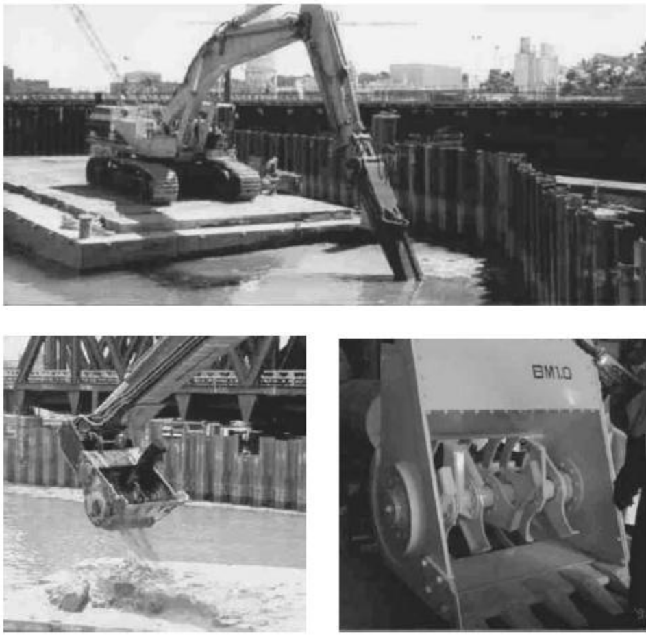
Slika 16: Oprema, uporabljena v projektu Fort Point Channel Site v Bostonu (Larsson, 2003).
