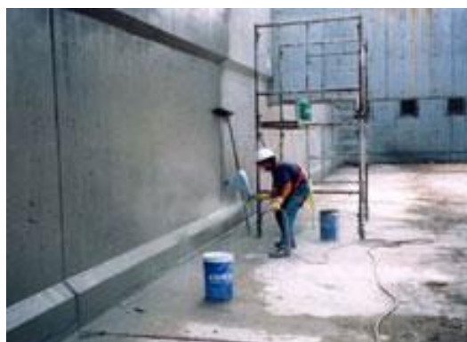
Slika 12: Detajl izvedbe KS: temeljna plošča – zunanja stena [1]
