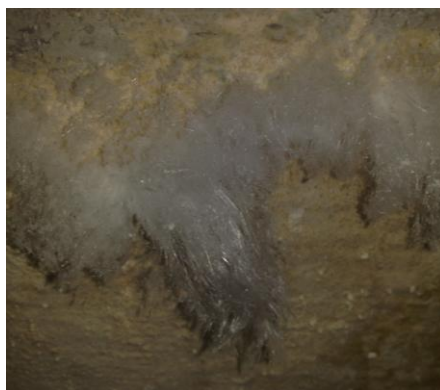
Slika 32: Kristalna vlakna, nastala pri sanaciji betonske razpoke [16]
