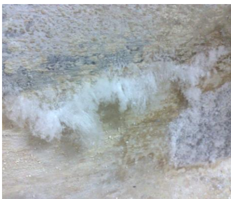
Slika 32: Kristalna vlakna, nastala pri sanaciji betonske razpoke [16]
