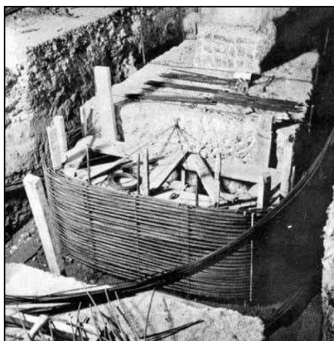
Slika A.3: Ogromen kompleks pristanišča Le Havre (levo); izvedba prednapetega betonskega nosilca, ki ga je Eugène Freyssinet predvidel v sklopu sanacije (desno) (Giovannardi, 2009).
