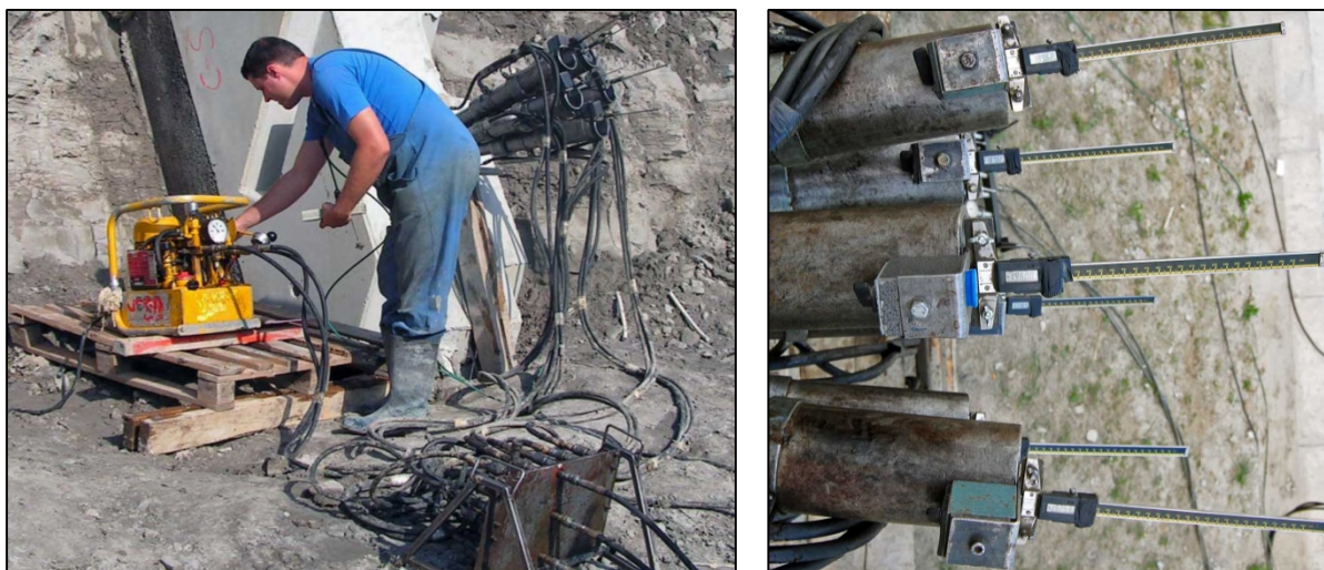
Slika 3.21: Sistem za preskušanje nosilnosti prednapetih pramenskih geotehničnih sider s posamičnimi napejalkami (levo), merilne urice za odčitavanje izvlečkov posameznih pramen (desno).
