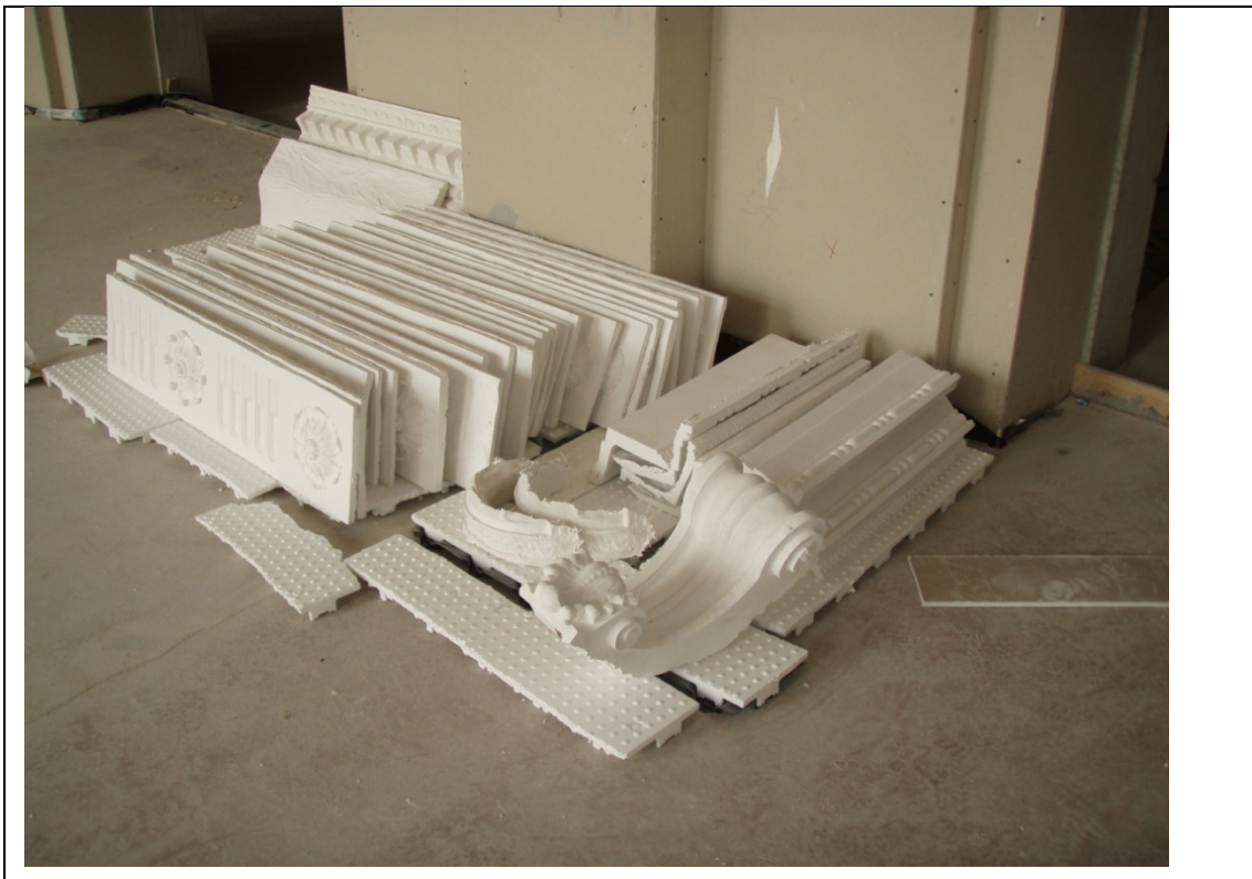
Slika 8: Obnovljeni štukaturni elementi. (Istrabenz hoteli Portorož d.o.o., 2007)
