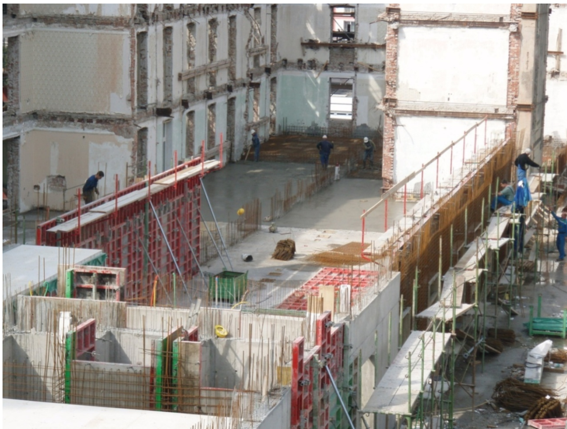
Slika 2: Prikaz novih armiranobetonskih (AB) sten v pritličju starega dela hotela. V ozadju na levi obstoječa opečnata stena ter na desni ohranjeno, prostostoječe historično stopnišče (Istrabenz hoteli Portorož d.o.o., 2006)
