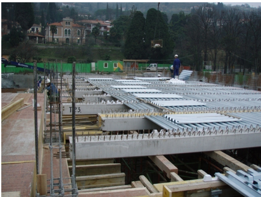
Slika 4: Prikaz izdelave armiranobetonske plošče nad medetažo v novem prizidku hotela s predhodno izdelanimi nosilci in nato postavljenimi na zidove. Opažni element med nosilci je trapezna pločevina, na katere sta položena rebrasta armatura in beton (Istrabenz hoteli Portorož d.o.o., 2006)
