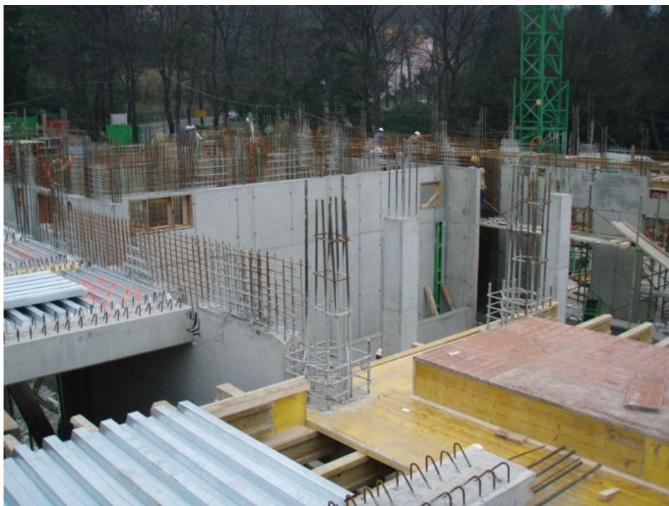
Slika 3: Prikaz armiranobetonskih sten in stebrov v pritličju novega dela hotela (Istrabenz hoteli Portorož d.o.o., 2006)
