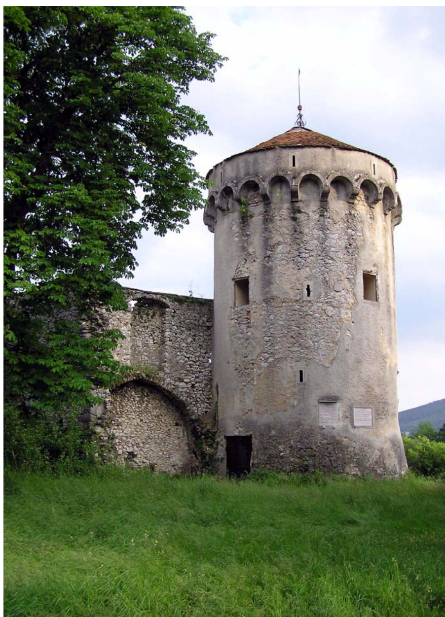
Slika 2: Grad Kalc pred obnovo leta 2010
