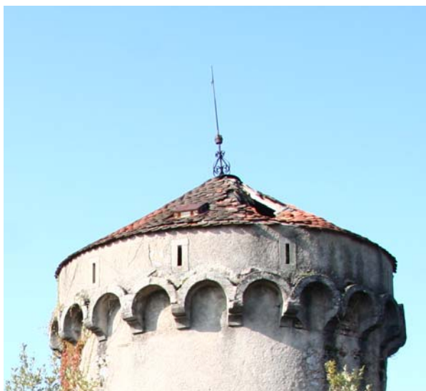
Slika 15: Oboki in vdrtja streha na stolpu
