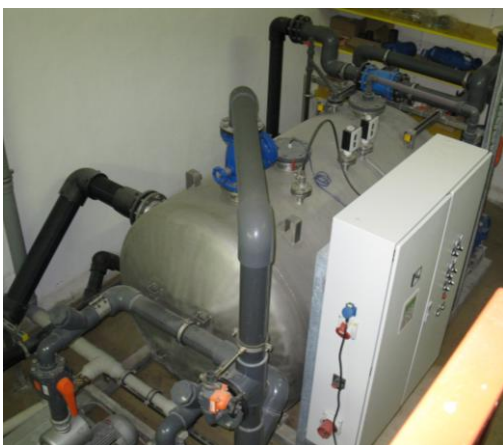
Slika 21: Vakuumska postaja Airvac v Logatcu
