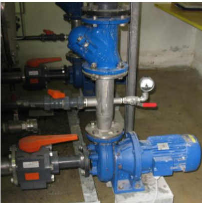
Slika 23: Tlačni črpalke v VP
