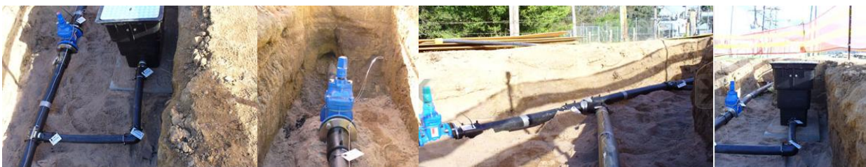
Slike 33: Sestavni deli tlačne kanalizacije (prevzeto: http://www.pssolutions.net.au/about.html )
