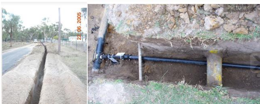
Slika 32: Na levi strani ozek jarek za tlačno kanalizacijo in na desni strani majhen premer tlačnega kanala v ozkem jarku ( prevzeto: http://www.pssolutions.net.au/about.html )
