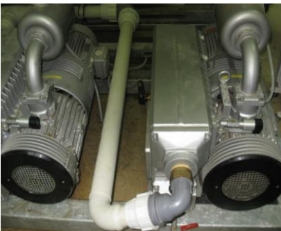
Slika 24: Vakuumski črpalke v VP
