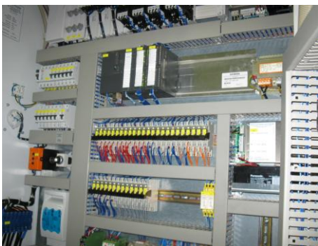
Slika 26: Krmilna postaja v vakumski postaji, ki v primeru napake javi na računalnik
