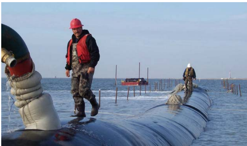
Slika 27: Polnjenje geotube (www.geotubes.com, 2010).
