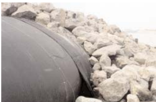
Slika 28: Oblaganje geotub s kamnito oblogo (www.geotubes.com, 2010).
