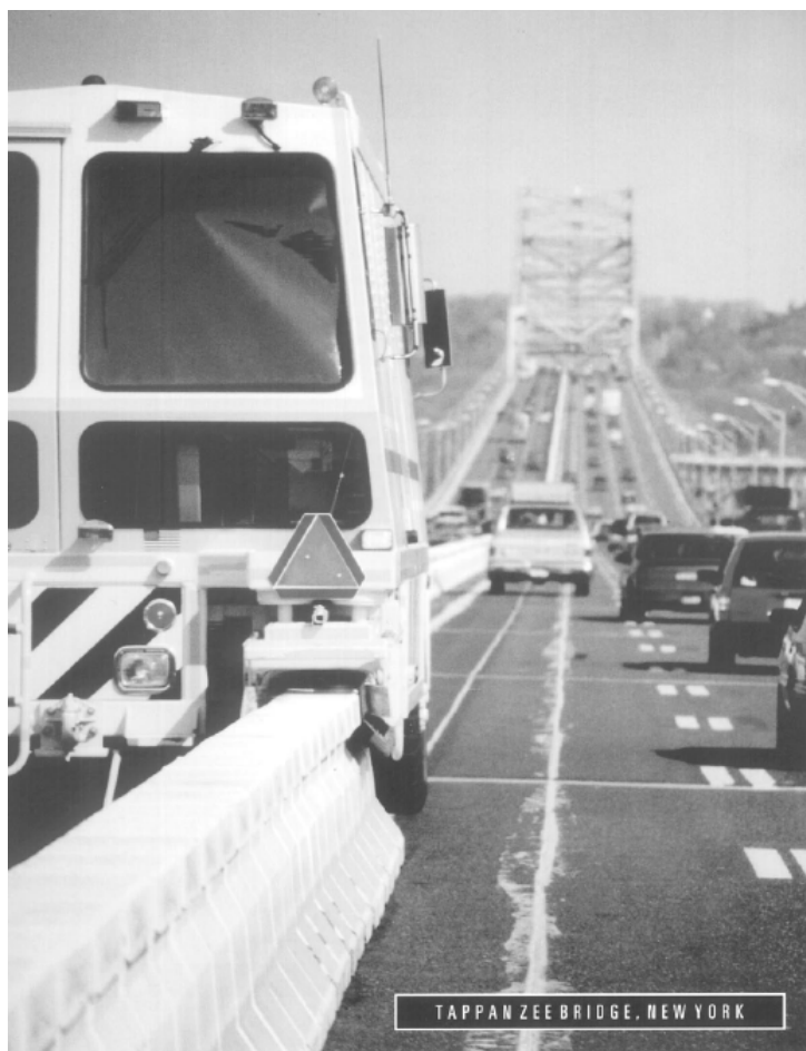
Slika 48: Po smeri spremenljiv prometni pas na mostu Tappan Zee, New York [2]
