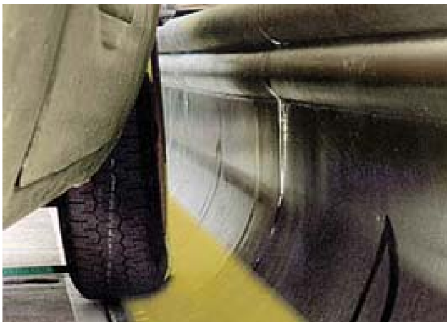
Slika 13: Prikaz povoznega dela ograje [1]
