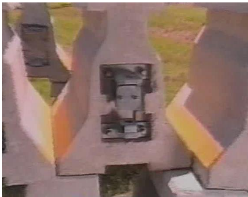
Slika 5: Jekleni zgib hitro prestavljive ograje [9]
