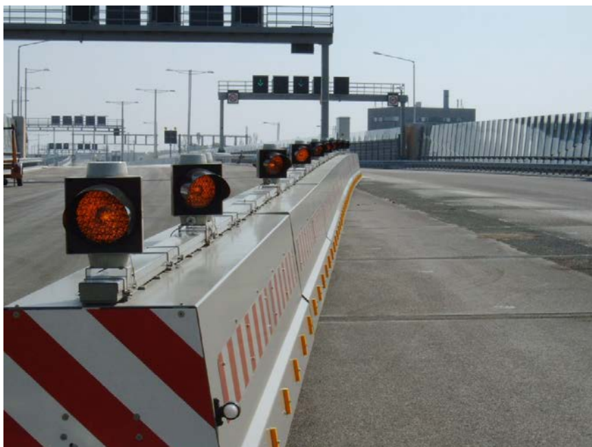
Slika 43: Drugačna oblika jeklene varnostne ograje [4]
