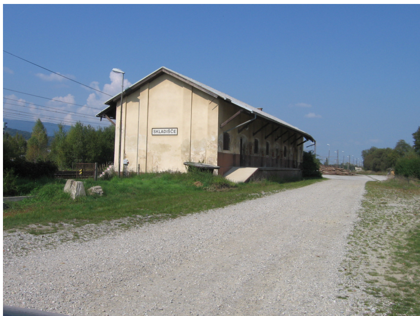
SLIKA 11: Tovorno skladišče Rače; leto gradnje 1844
