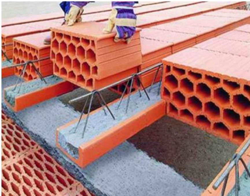
Slika 25: Sistem z opečnimi polnili in nosilci (spletna stran Wienerberger)
