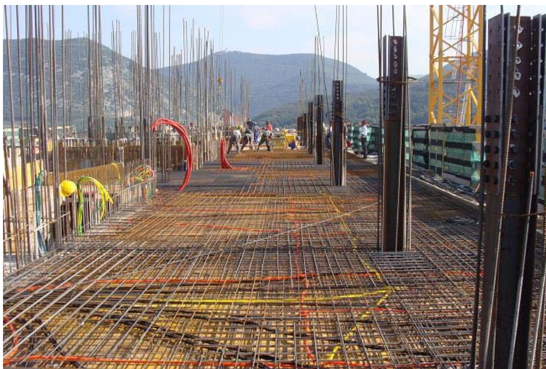
Slika 19: Armatura plošče z ojačitvami – plošča pripravljena za betonažo
