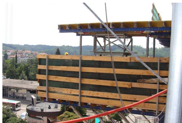
Slika 16: Opažna miza na vozičku čaka žerjav, da jo dvigne etažo višje
