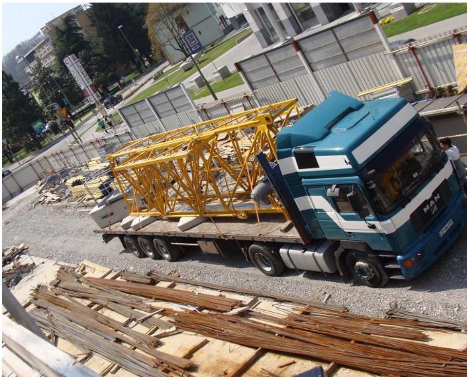
Slika 27: Gradbiščna pot in deponija armature
