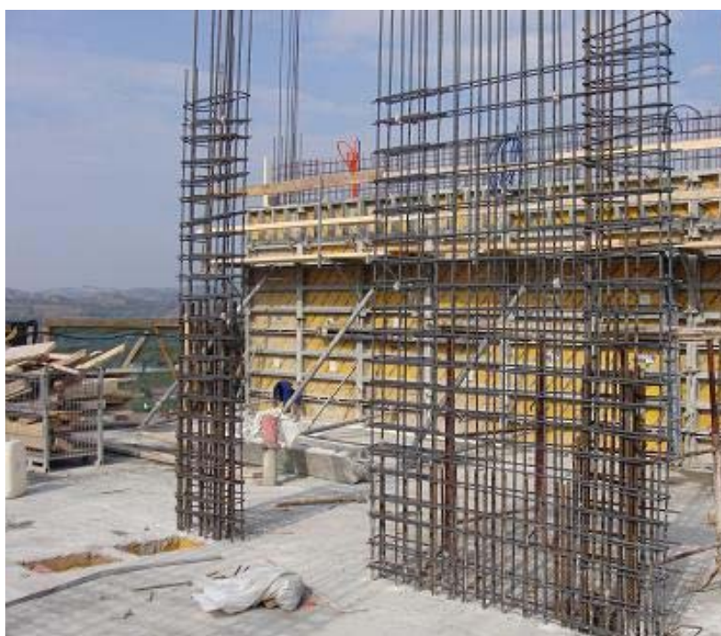
Slika 11: Armirana slop in stena, pripravljena na opažanje
