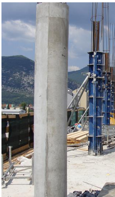
Slika 7: Zabetoniran in razopažan sovprežni steber
