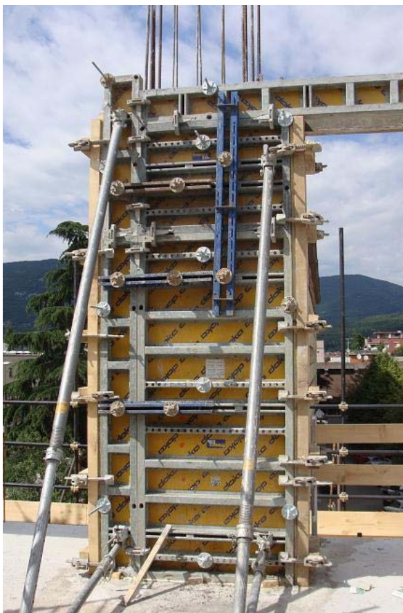
Slika 12: Zaopažan slop – stenski Doka Framax X-life opaž z oporniki
