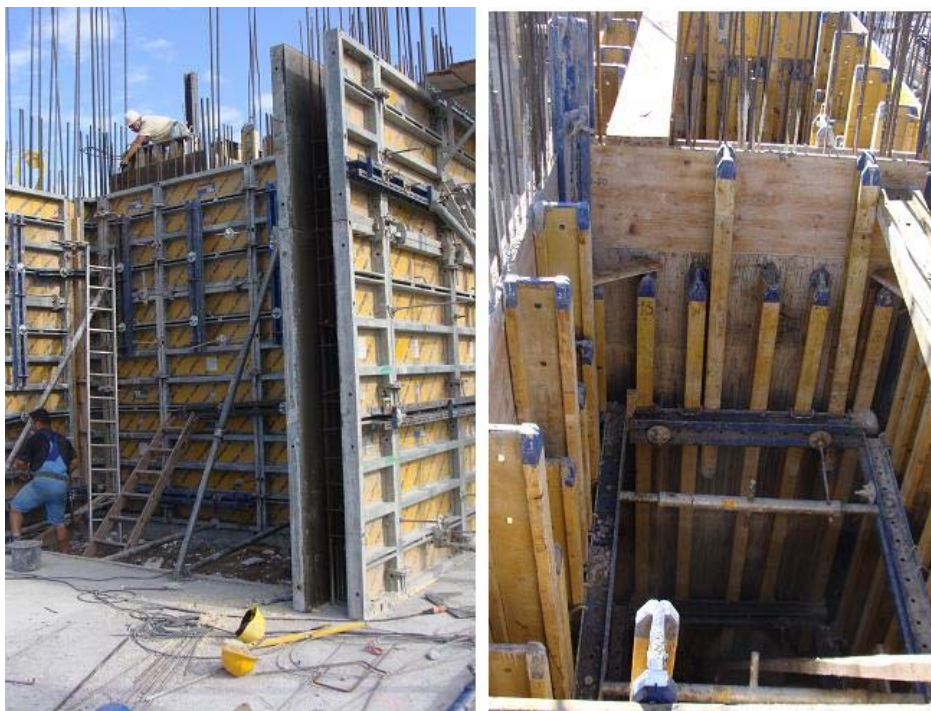
Slika 9: Zunanji opaž jedra – Framax X-life (levo), notranji opaž inst. jaškov jedra (desno)
