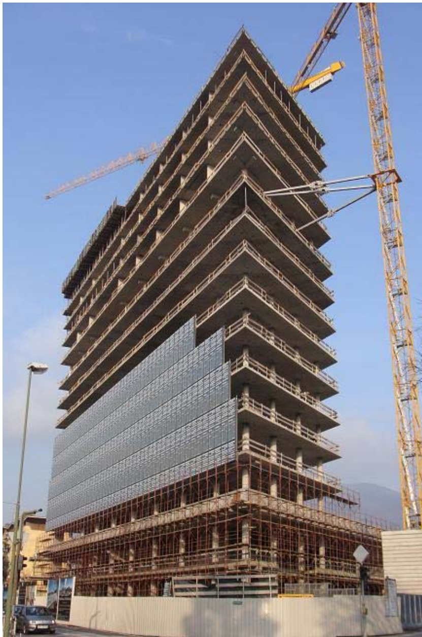
Slika 1: Eda center – končana AB konstrukcija
