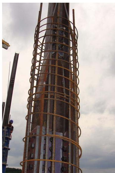
Slika 5: Vijačeni spoj jeklenega profila in armaturni koš – steber pripravljen za opaž
