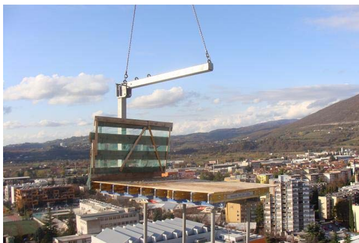
Slika 17: Žerjav z Doka DM vilicami prenaša konzolno mizo s podesta na naslednjo etažo
