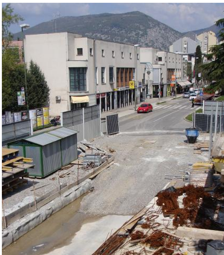
Slika 24: Pomožni vhod v gradbišče in deponija armature
