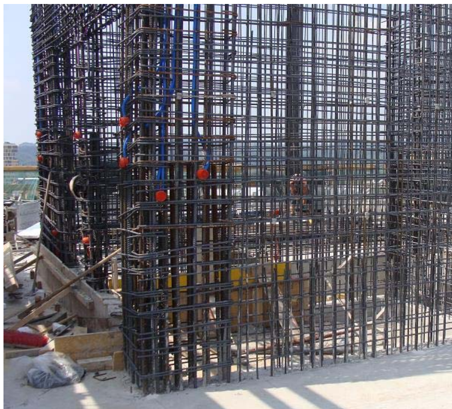
Slika 8: Armatura jedra z elektroinstalacijami – jedro pripravljeno za opaž
