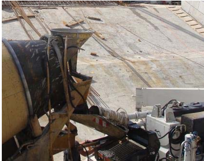
Slika 32: Avtomešalec vzvratno »priključen«, vliva beton v zbiralnik avtočrpalke
