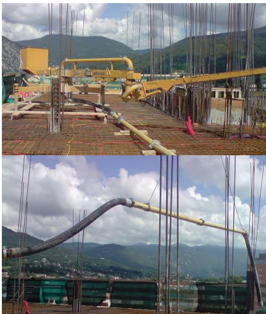
Slika 30: Distributor betona (zgoraj), podaljšek cevi, ki ga drži žerjav (spodaj)
