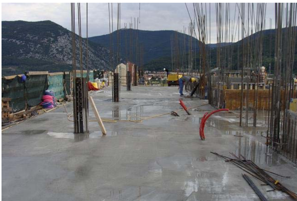
Slika 22: Plošča je zabetonirana, izvaja se nega betona
