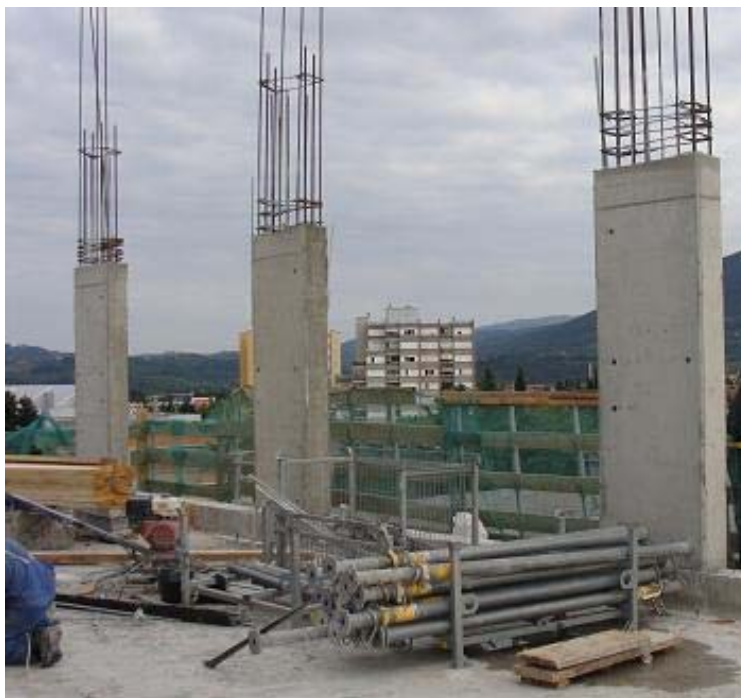
Slika 13: Zabetonirani in razopažani slopi
