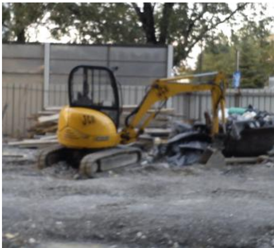
Slika 34: Minibager opravlja manjša opravila po gradbišču
