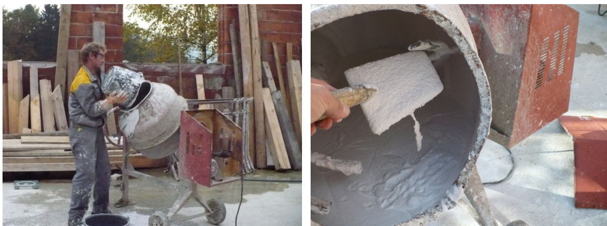
Slika 14: Mešanje in izgled gotove fine malte
