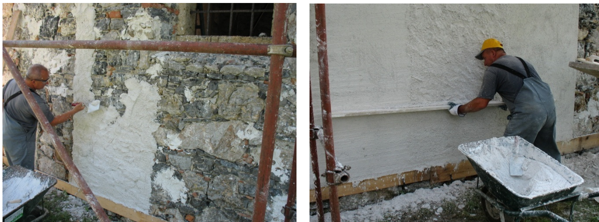
Slika 10: Nanašanje grobega ometa in horizontalna poravnava z leseno poravnalno letvijo
