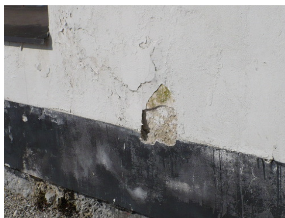
Slika 2: Poškodbe apnenega fasadnega ometa zaradi neprimerne barvnega premaza
