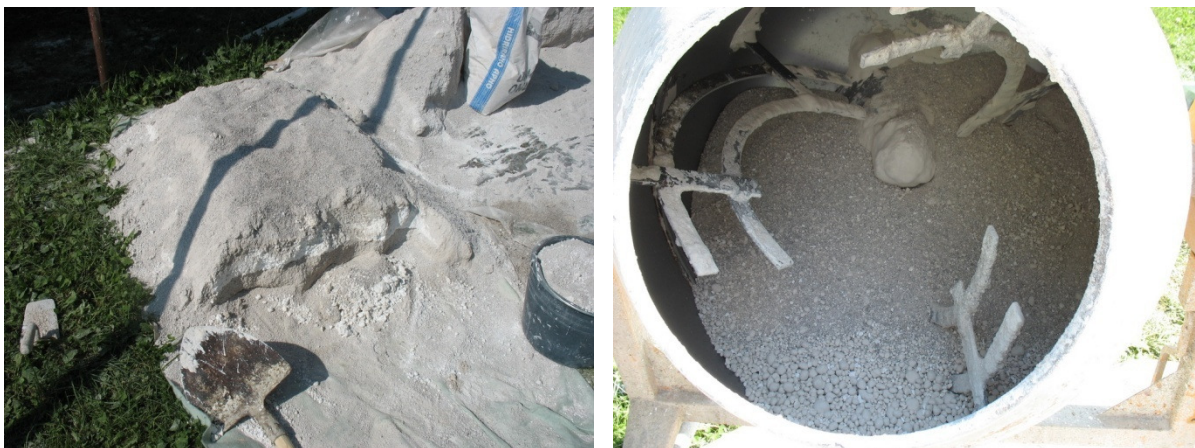
Slika 8: Odvzem peska z apnom iz gomile in prvi cikel mešanja brez dodane vode
