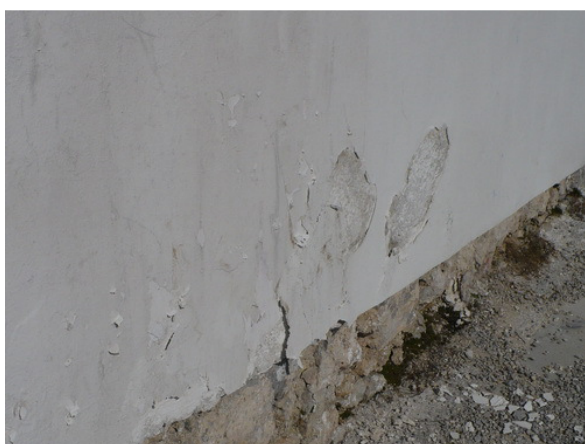
Slika 2: Poškodbe apnenega fasadnega ometa zaradi neprimerne barvnega premaza
