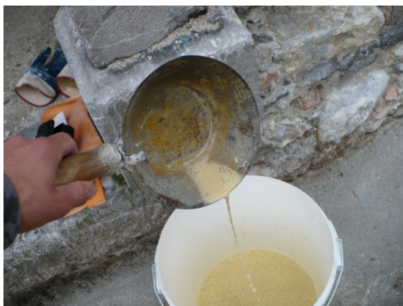
Slika 17: Priprava premaza (barve) in slikanje fasade na še sveže vzorce finega ometa
