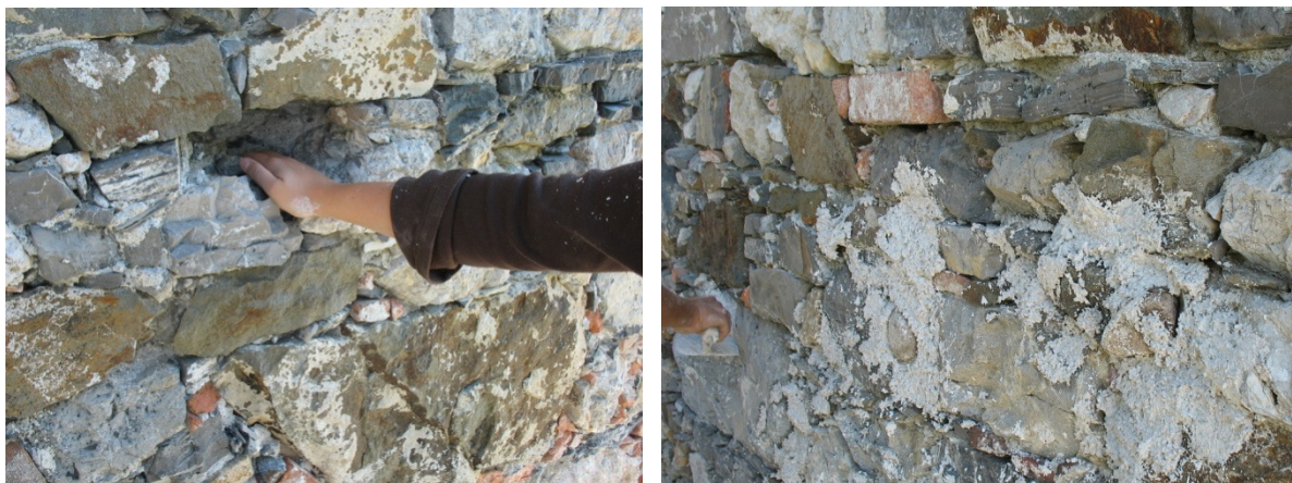
Slika 4: Očiščena podlaga s prikazom velikosti povprečne luknje in kranje le teh
