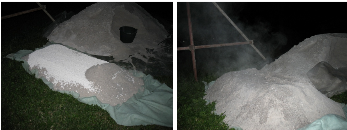
Slika 7: Priprava gomile iz živega apna in peska ter gašenje apna v pesku (gomili)
