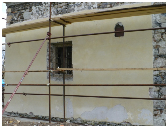
Slika 45: Prikaz stanja vzorcev fasadnih ometov na dan 10. 11. 2007 (17 dni star fini omet in oplesk) in na dan 9. 4. 2008 (168 dni star fini omet in oplesk)
