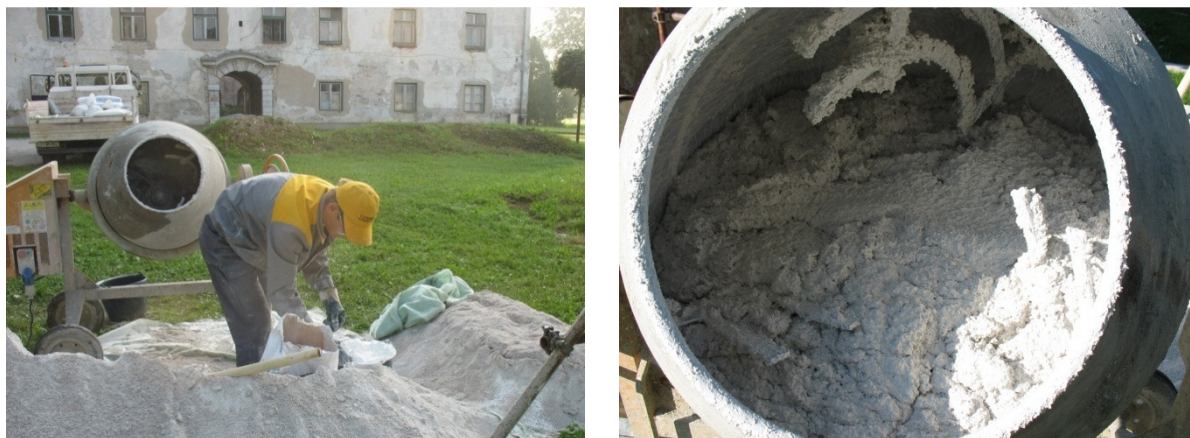
Slika 6: Izdelava grobe malte in izgled gotove (primerne) malte v mešalcu
