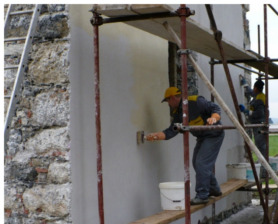
Slika 17: Priprava premaza (barve) in slikanje fasade na še sveže vzorce finega ometa
