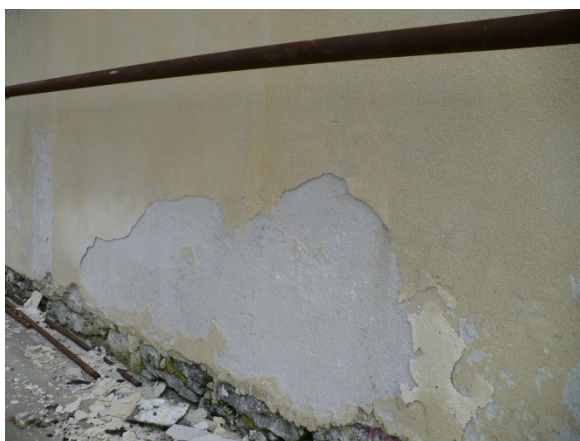
Slika 46: Odstopljeni fini omet ( If, IIf in IVf )
