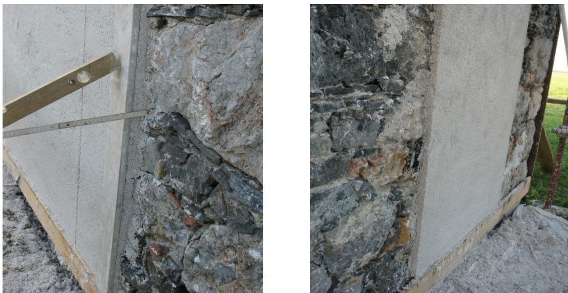
Slika 11: Prikaz debeline vzorcev grobih ometov
