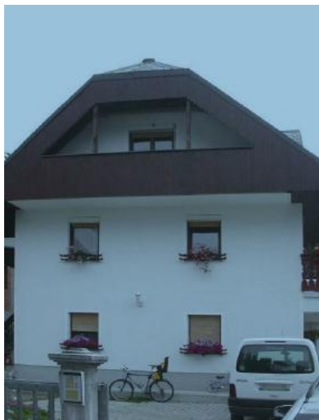
Slika 2: Hiša v Bovcu iz porobetona, ki je leta 2004 prestala potres z magnitudo M=4,7 (v bližini PGA 0,46g) brez poškodb (vir: U. Klemen)
