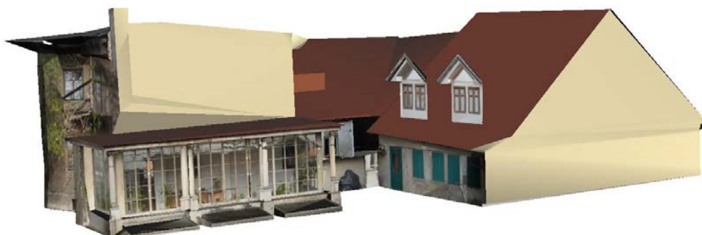
Južna fasada in zahodna dvoriščna fasad
