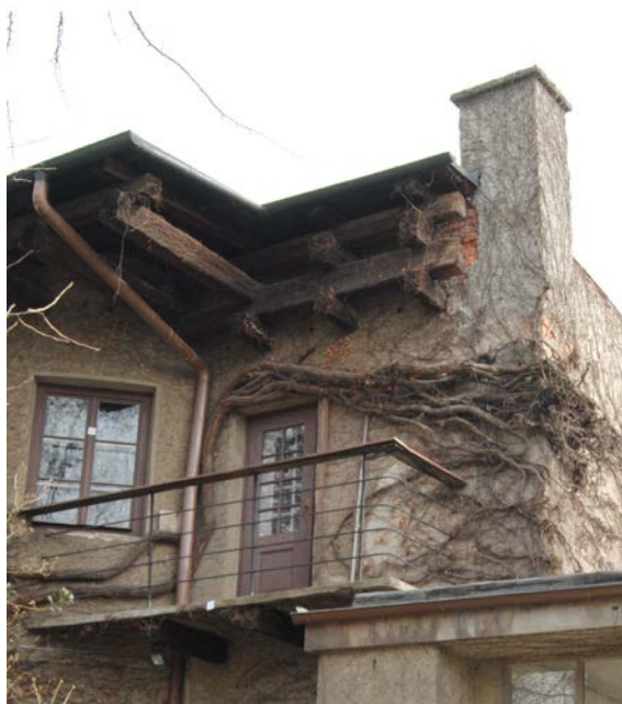
Slika 29: Strešni tramovi valjastega prizidka, katere smo v modelu poenostavili.
