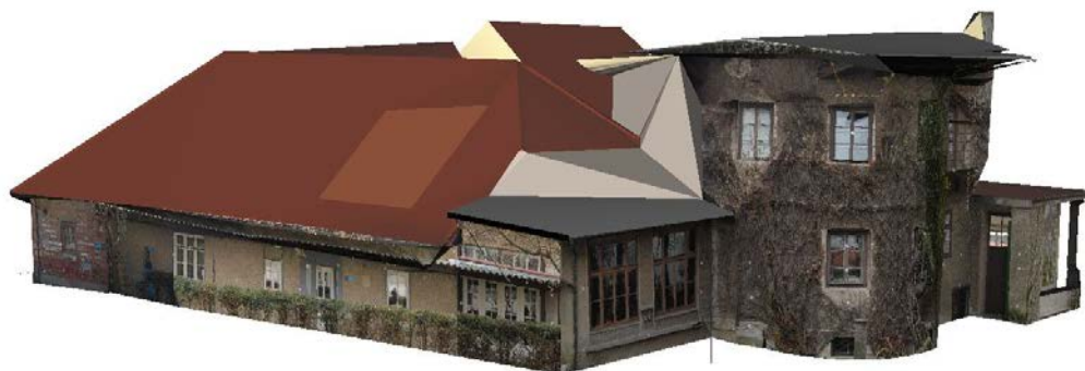
Severna in zahodna fasada
